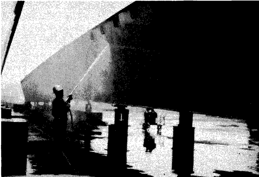
高圧洗浄による水洗い。
