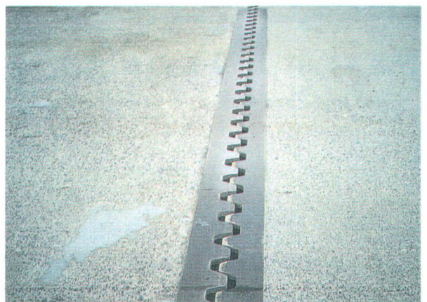
写真-4 改修前の足利側ジョイント部
