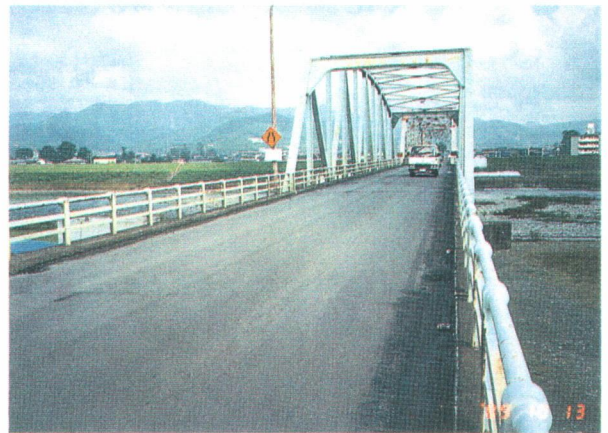
写真-2 改修後の路面状況
