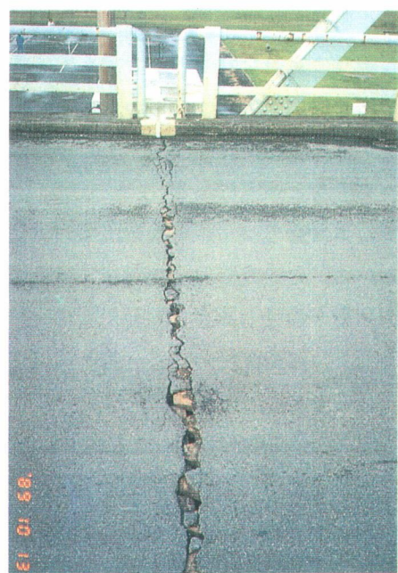
写真-6 改修後の足利側ジョイント部
