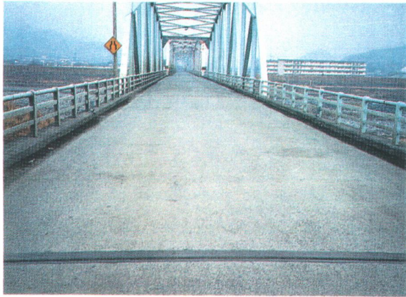
写真-1 改修前の路面状況
