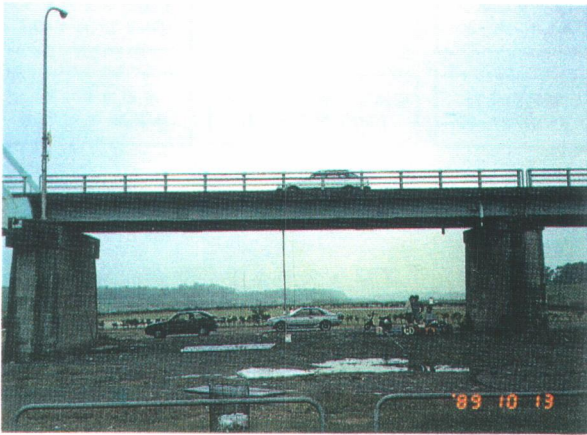
写真-7 騒音・振動測定状況
