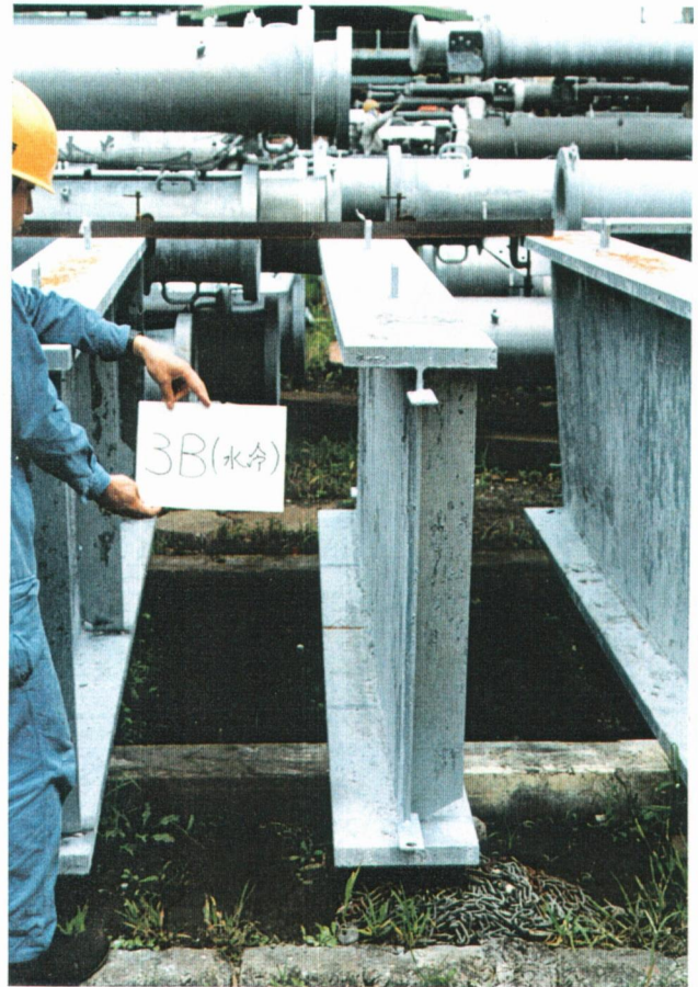
写真3.4 亜鉛めっき後の変形状態の一例
