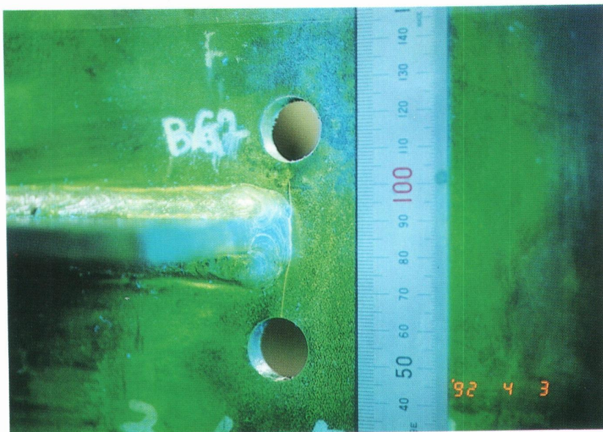
3 体目 G 2 ガセットの ストップホール の孔明け状況
