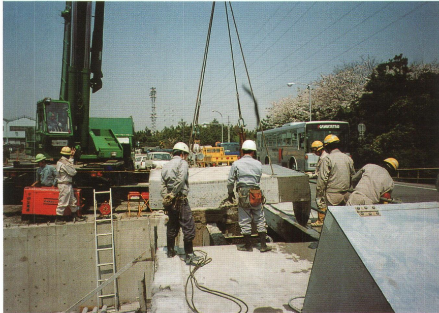
写真 2 - 5 R C 床版の撤去
