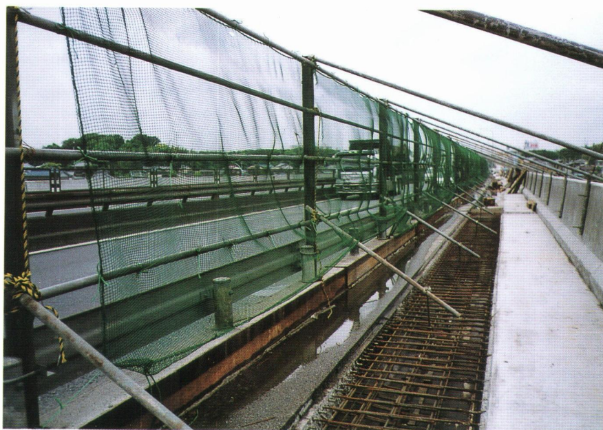
写真 2 - 3 拡幅部の継ぎ手構造
