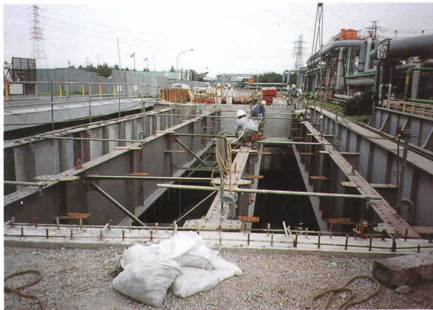
写真 2 - 6 新設桁の架設
