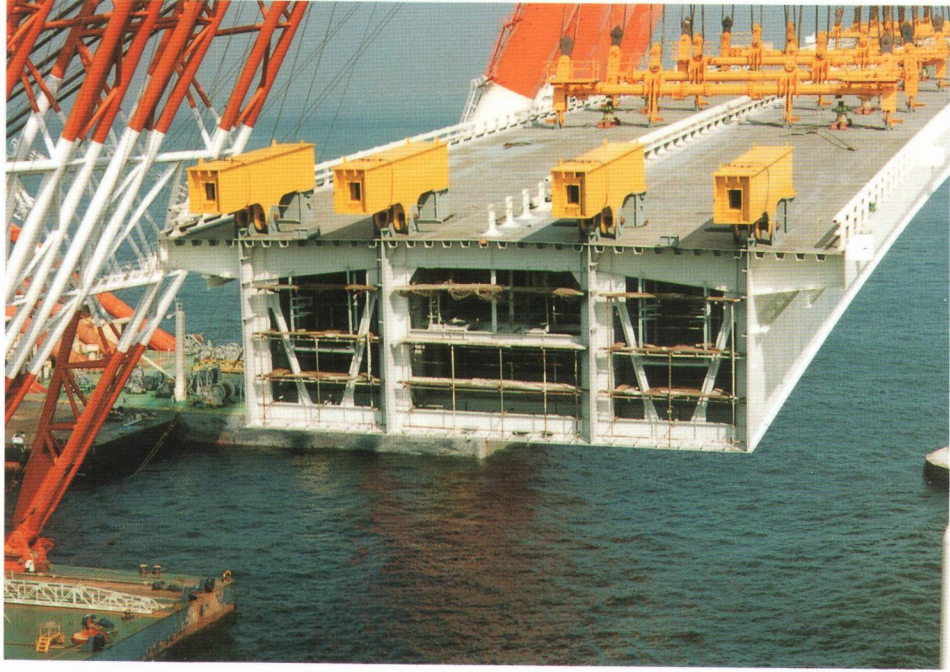
写真 2 - 9 拡幅前の幅員
