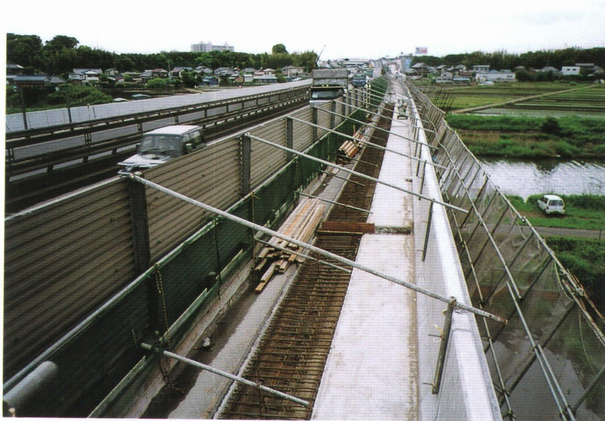
写真 2 - 2 R C床版の拡幅部
