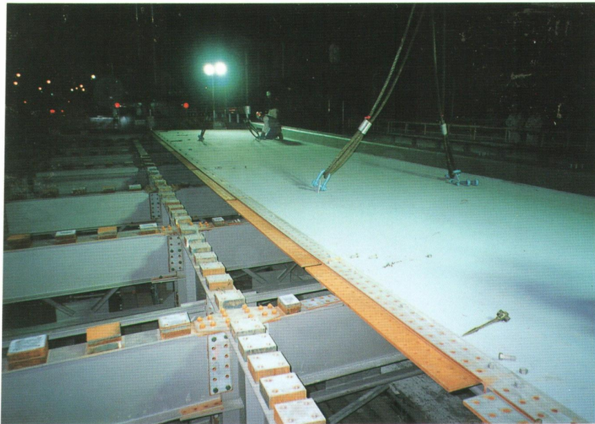
写真 2 - 8 新設鋼床版の架設
