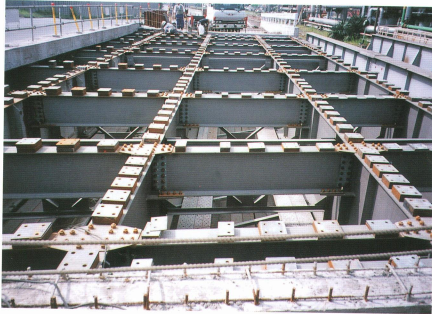
写真 2 - 7 横桁・ファイラ-プレート ® の取付
