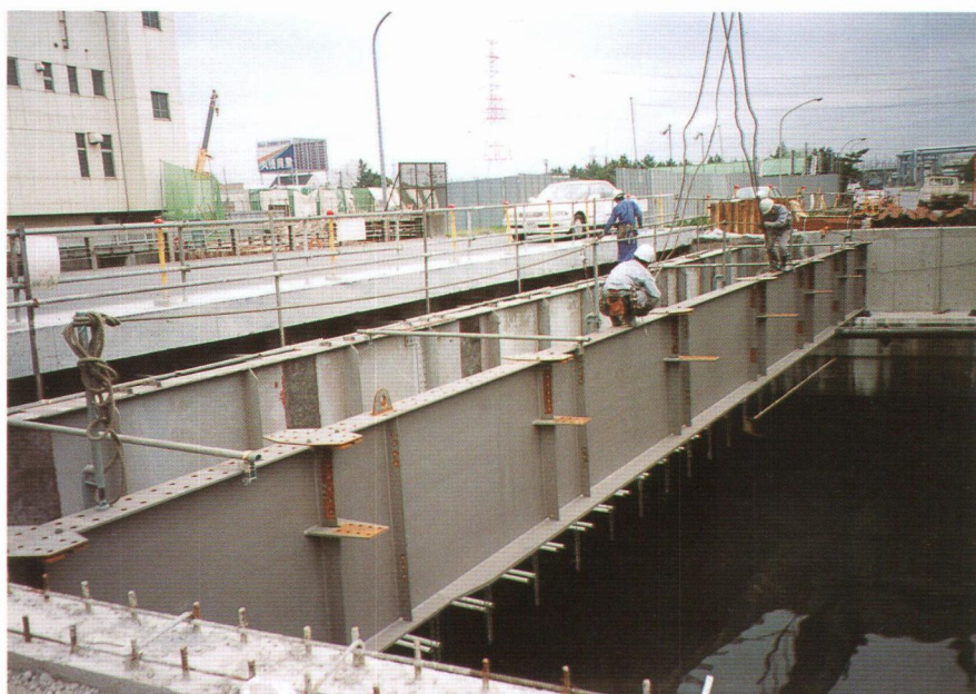
写真2-1 拡幅工事の一例
