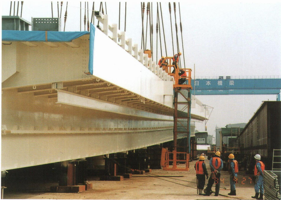
写真 2 - 10 将来拡幅の仕口部
