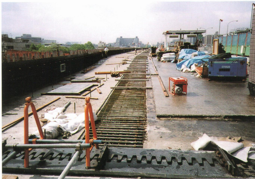
写真 3 - 1 RC床版の拡幅
