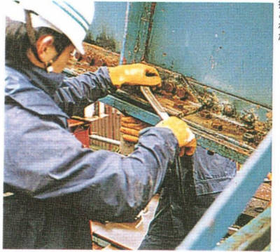
▶バックルプレートの取りはずし。
