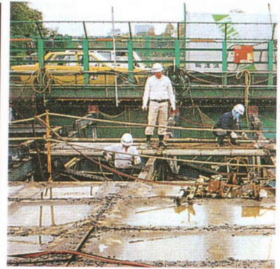
▶バックルプレートの取りはずし。
