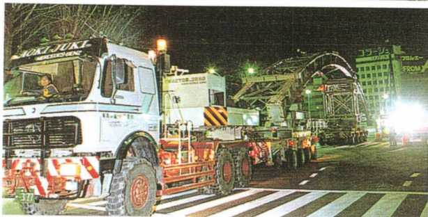
解体作業は、橋体再利用のため、極めて慎重に行なわれ、また撤去作業においては現場がJR四ツ谷駅上であるため、深夜クレーンで吊り出し、三分割して輸送された。(平成元年11月/写真提供：鉄建建設)
