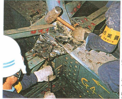
◀解体前に一度リベットをはずし、ボルトに交換された
