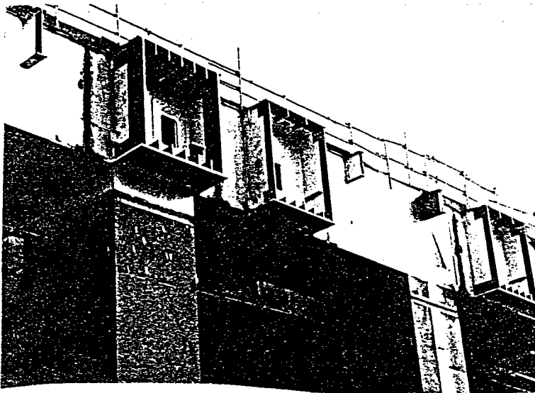
写真 - 4 首都公団：板橋戸田線 IS工区 鋼橋脚の柱及び剛結横梁の現場溶接
