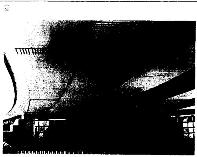
桁下面外装はルーバーを横軸に並べている。鋼箱桁下面は桁下面外装との一体感をはかるため同じ色で塗装している。
