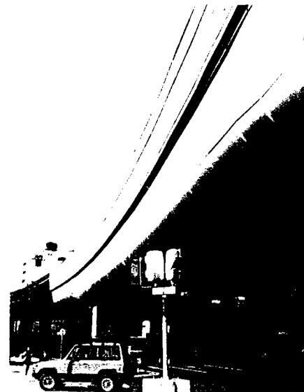
桁カバーは、三次元曲面により側面から下面まで回り込んでいる。
