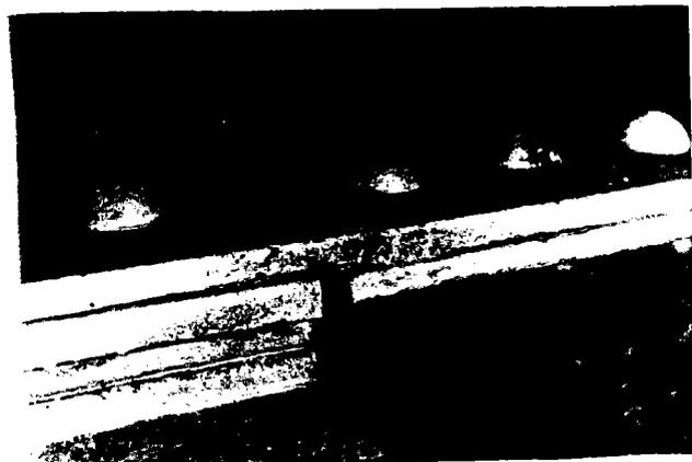
図-10.4 仮付け溶接部から発生した連結板の亀裂
