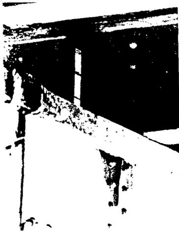
図-15.3 道路伸縮継手位置でフラケットの上の縦桁複成に生じた亀裂 Delaware River Port Authority の好意による
