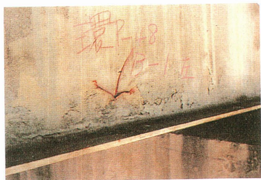
写真 4.41 箱桁外面の損傷状況
