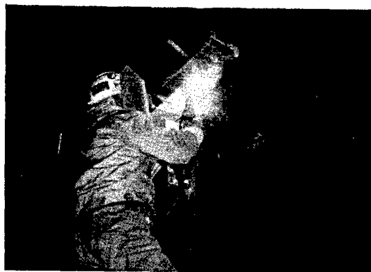
鈹桁側の溶接
