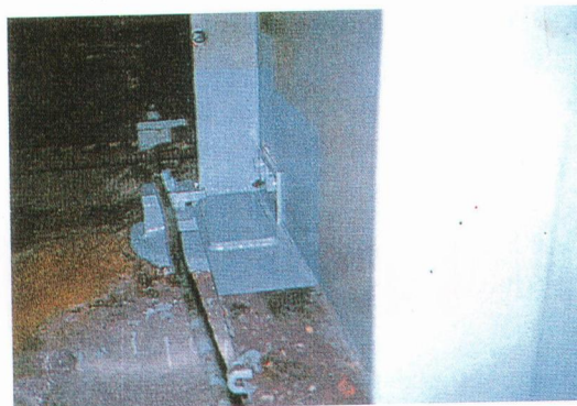
写真 4.10 補修完了 (I 桁)
