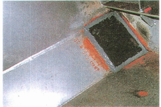
写真 4.22 コーナープレートの撤去跡のシール
