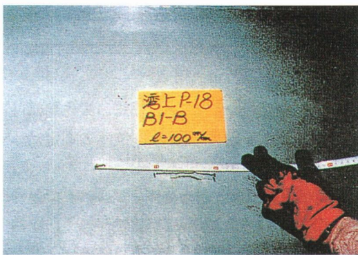
写真 4.95 移動量不足による母材のわれ (その2)
