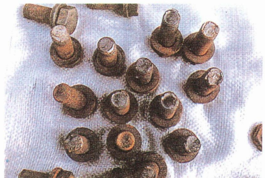
写真4.79 損傷高力ボルトの回収状況
