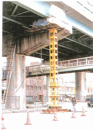
写真 4.4 補修状況の全景
