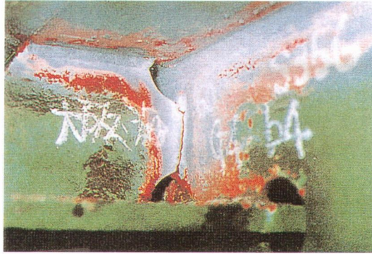
写真 4.14 タイプ3の損傷
