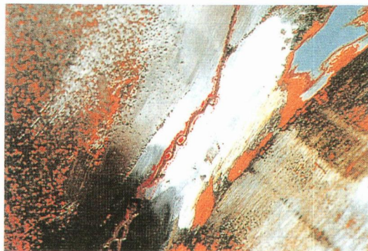
写真 4.2 腹板と下ラウンジ部のわれの状況
