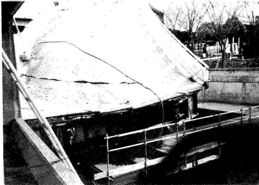
(1) 湊川ランプ橋の落下した曲線桁
