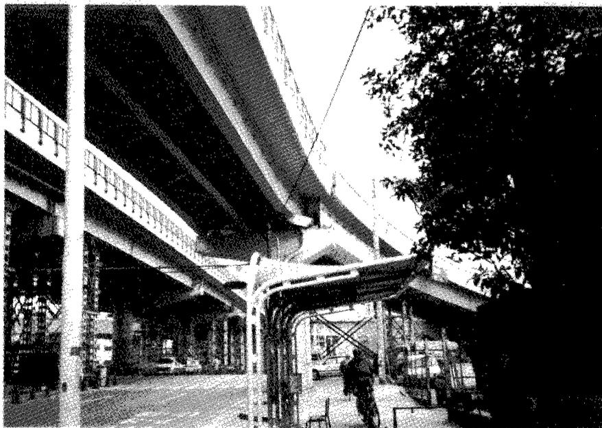
(2) 湊川ランプ橋における桁の橋軸直角方向へのずれ
