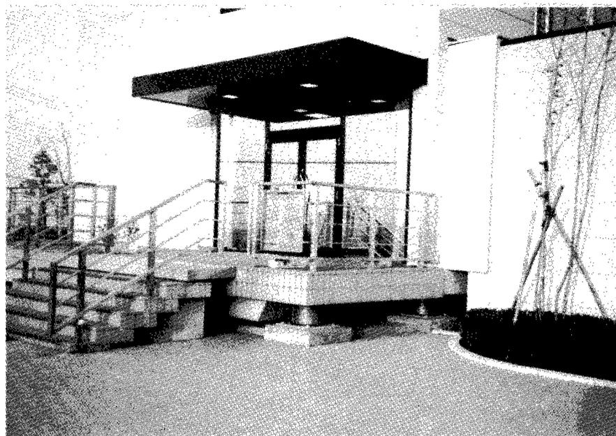
写真-4.1.2 免震構造の事務所棟（オイレス工業足利工場）
