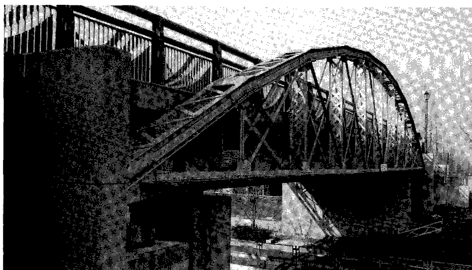
写真1 緑地西橋に保存されているもと心齋橋のドイツ製トラス(主構のみ保存)
