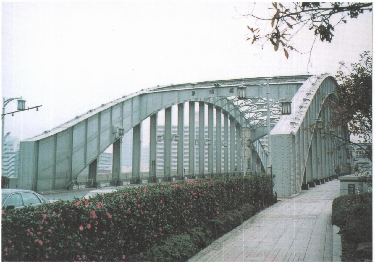
築地側からみたアーチ橋
