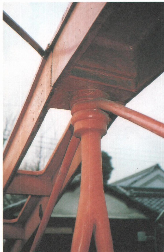
垂直材上方に斜材の環がはまる
