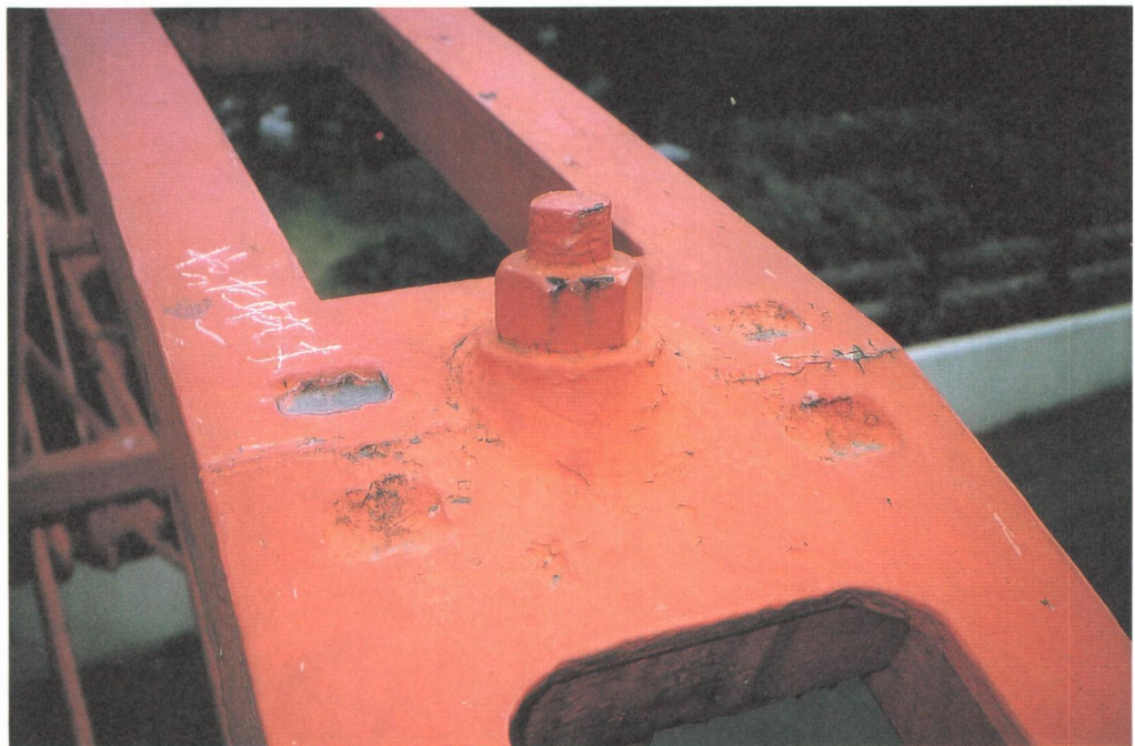
垂直材の上端は上弦材上面に出てナットで締めてある
