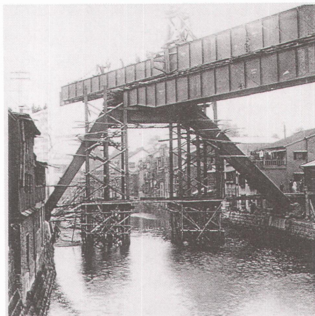
架設中の神田川橋梁 1)
