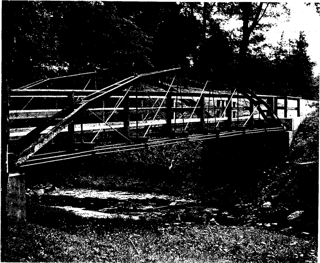
写真4 ユニオンカレッジに移設保存されたカヤダッタ・クリーク橋 9)
