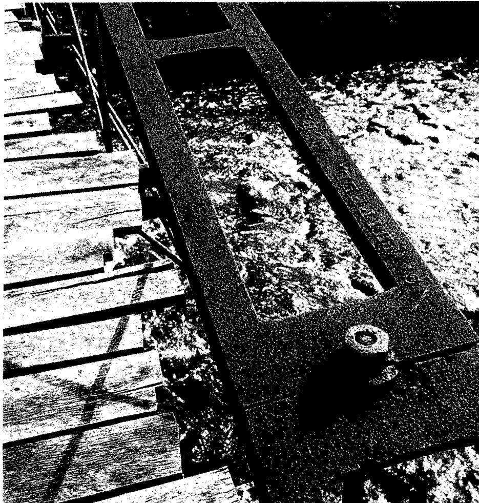
写真3 カヤダッタ・クリークに架かるアーチトラス橋 8) S. WHIPPLE, ALBANY, N. Y. 1869の陽刻がある.
