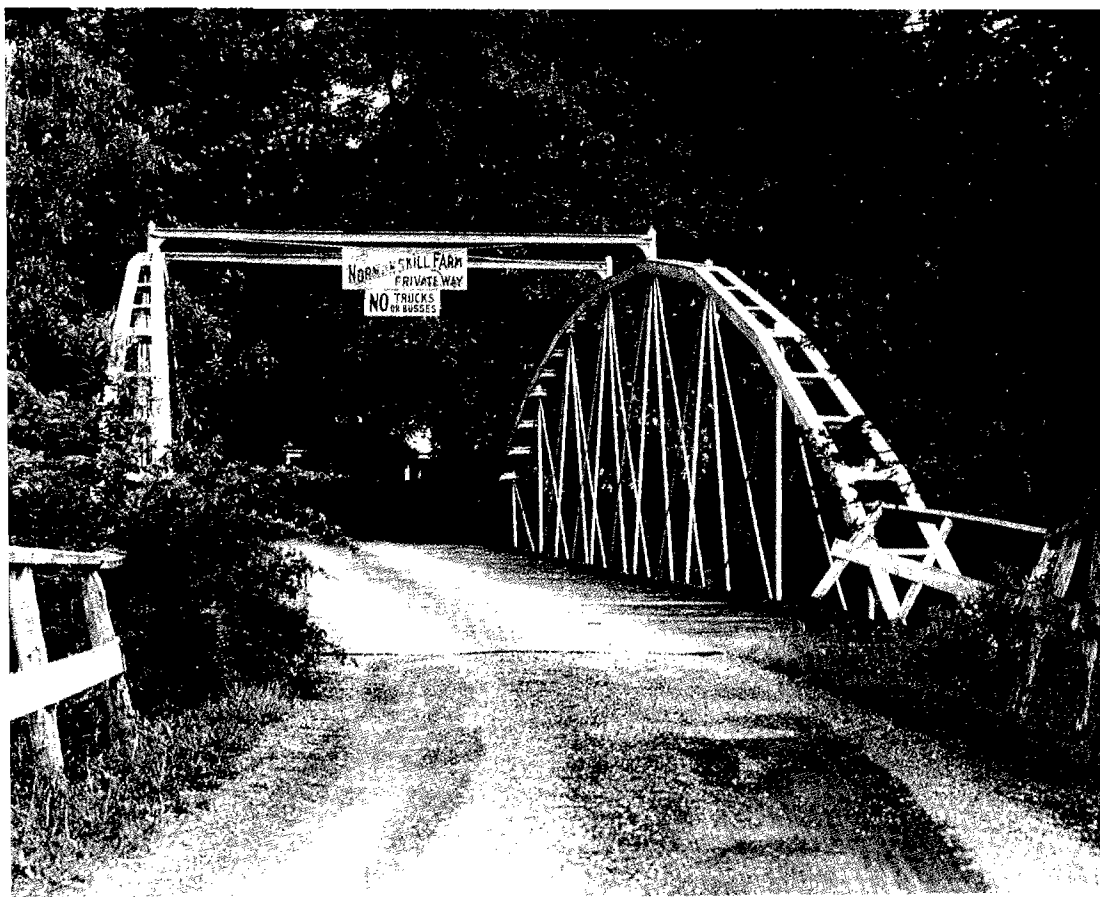
写真1 ノーマンスキル農場のホイップル・アーチトラス橋 6)
