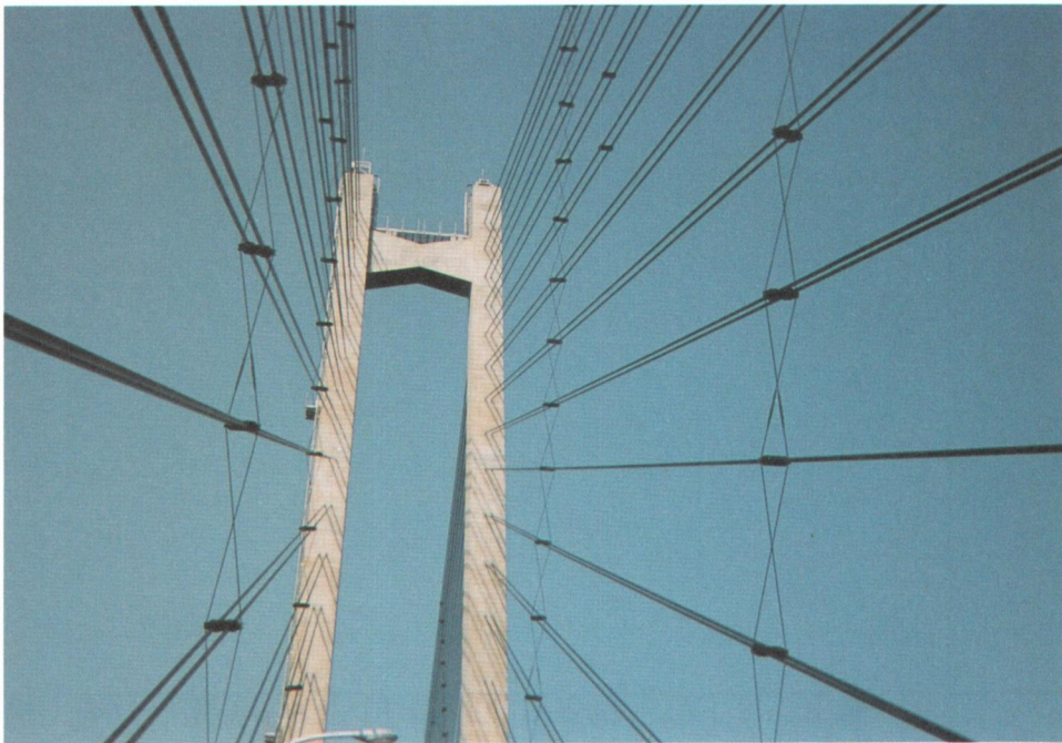
写真 呼子大橋 ケーブル連結
