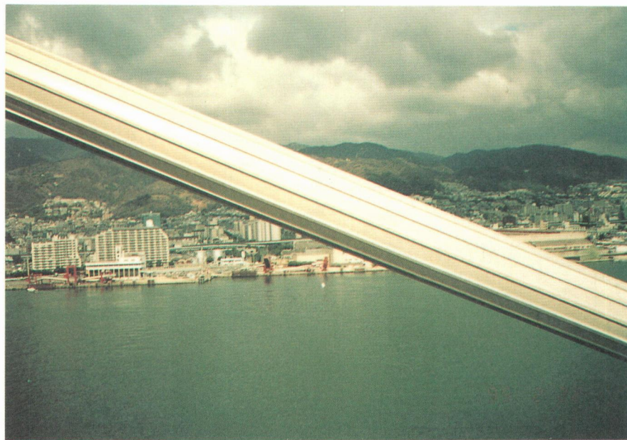
写真 東神戸大橋 制振突起付き（平行突起）ケーブル
