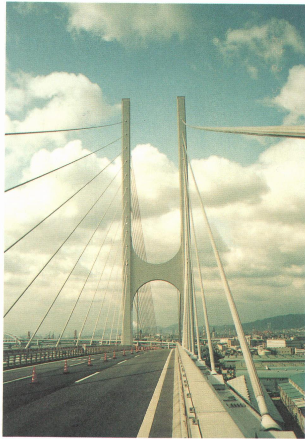
写真 東神戸大橋
