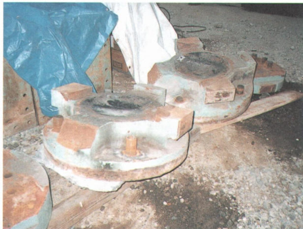
写真 2.3.6 P690 可動支承
