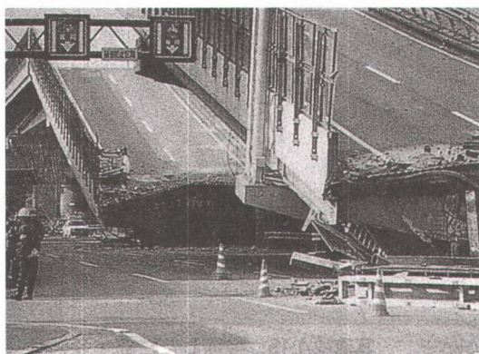
写真1.1.2 落橋した橋梁
