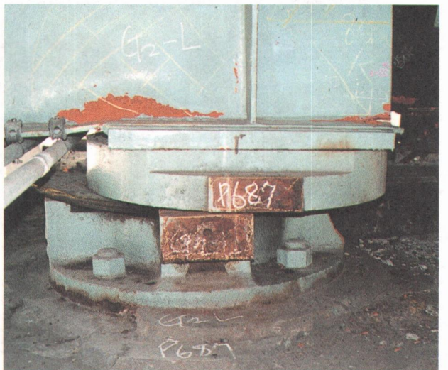
写真 2.3.8 P687 可動支承
