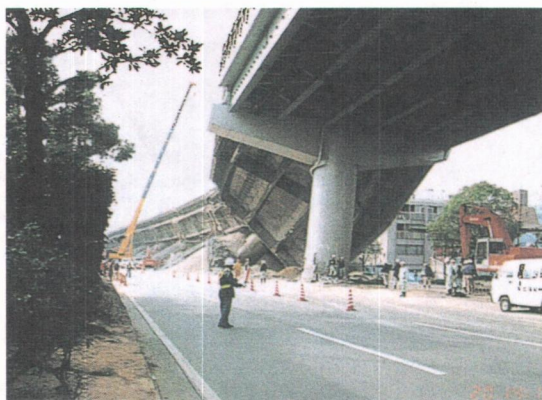
写真1.1.1 ピルツ橋の倒壊
