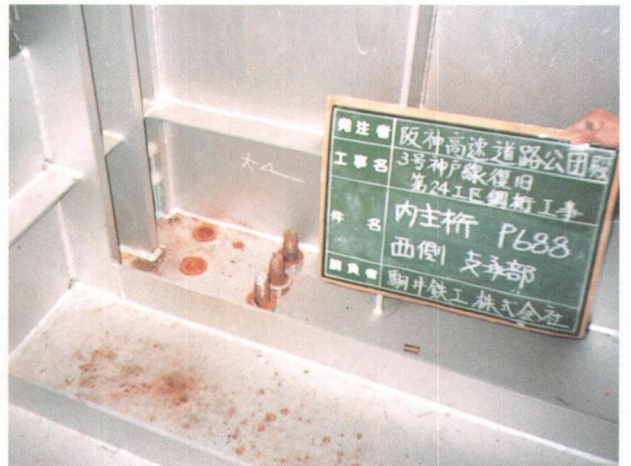
写真 2.3.9 P688 固定支承のセットボルト切断
