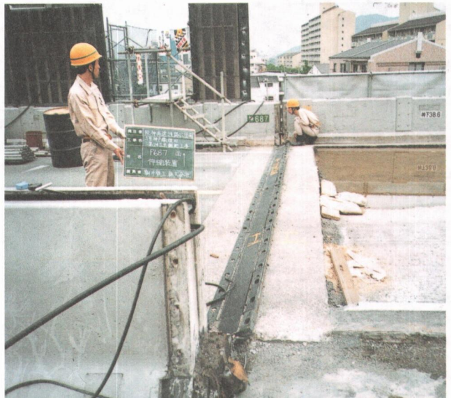
写真 2.3.4 伸縮装置の損傷 (P678)
