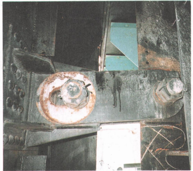
写真 2.3.3 落橋防止装置の損傷 (P678)
