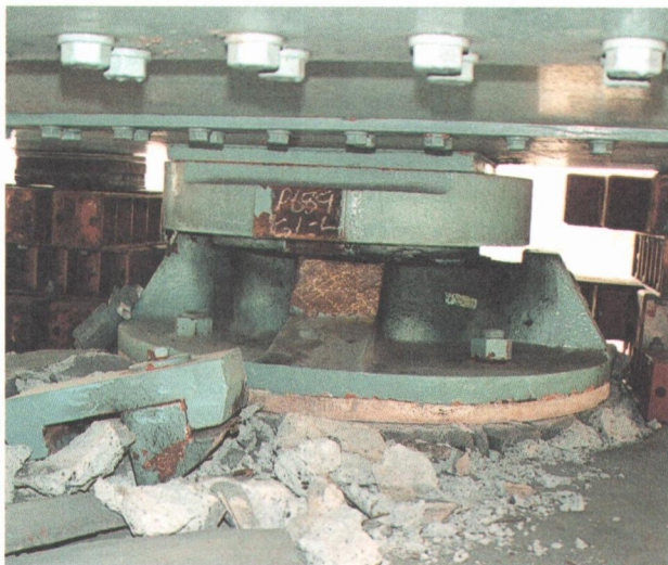
写真 2.3.7 P689 可動支承
