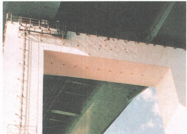
写真1.2.6 橋脚梁部のパネルせん断座屈
