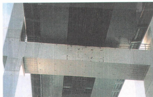
写真1. 2. 16 鋼製橋脚横梁のせん断座屈
