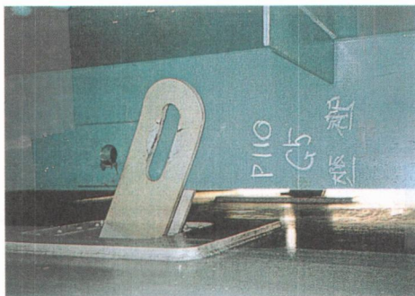
写真1. 2. 12 ピンの抜け落ち
