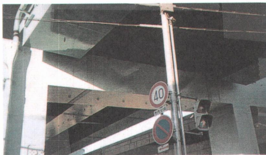
写真1. 2. 15 鋼製橋脚横梁のせん断座屈
