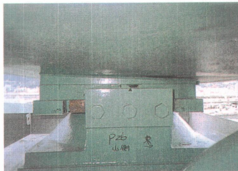
写真1. 2. 14 可動支承遊間の詰まり
