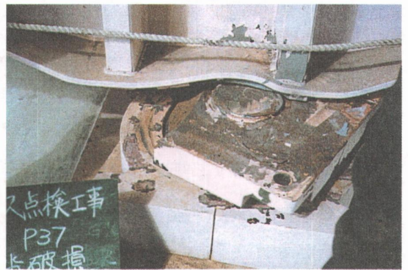
写真 1. 3. 7 支承の損傷
