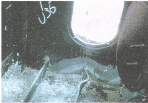
写真 1. 3. 5 支点上ダイアフラムの損傷
