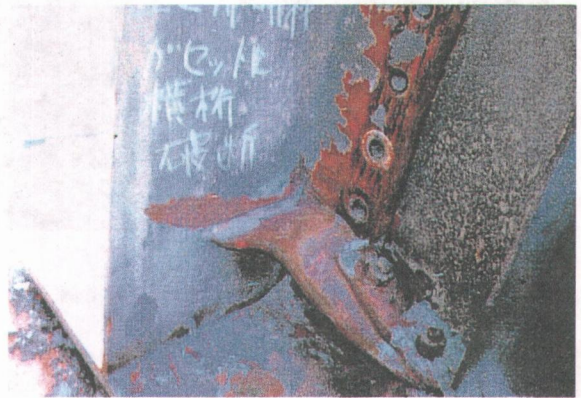
写真 1.3.3 端横桁取り付け部の損傷
