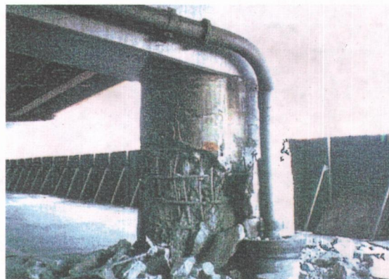
写真 1.3.10 RC 橋脚の損傷
