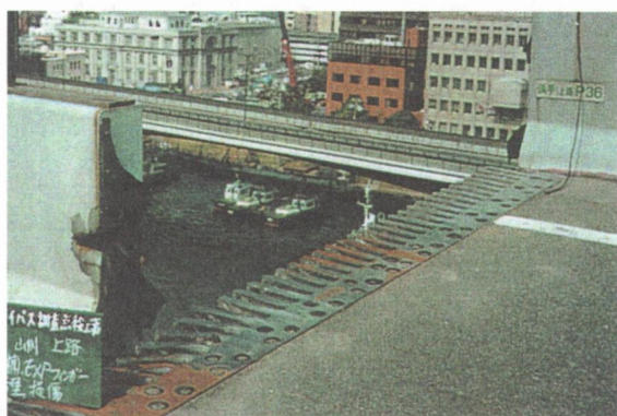
写真 1.3.9 鋼製フィンガーの変形
