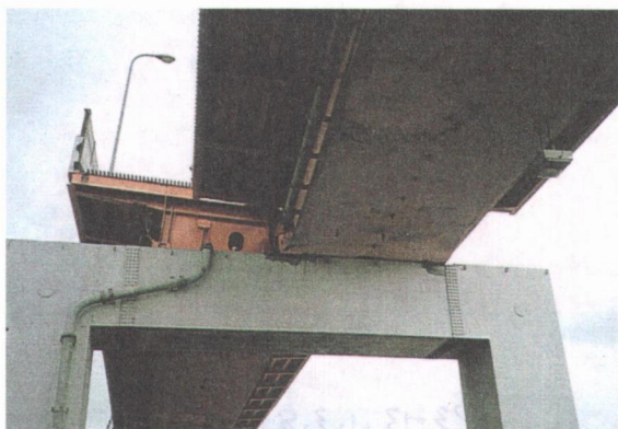
写真 1.3.8 桁端部の全体移動
