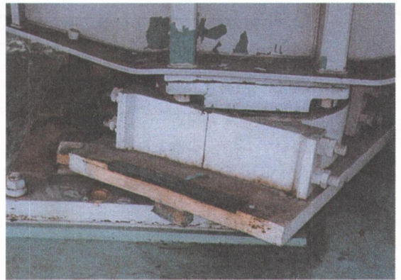
写真 1. 3. 6 支承の損傷
