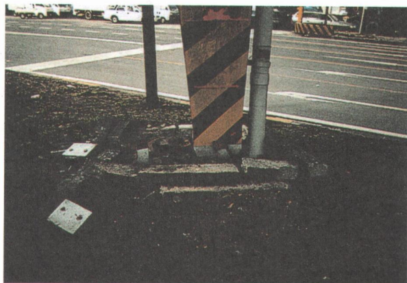
写真 4. 1. 6 P2 橋脚基部のピボットシューからの脱落
