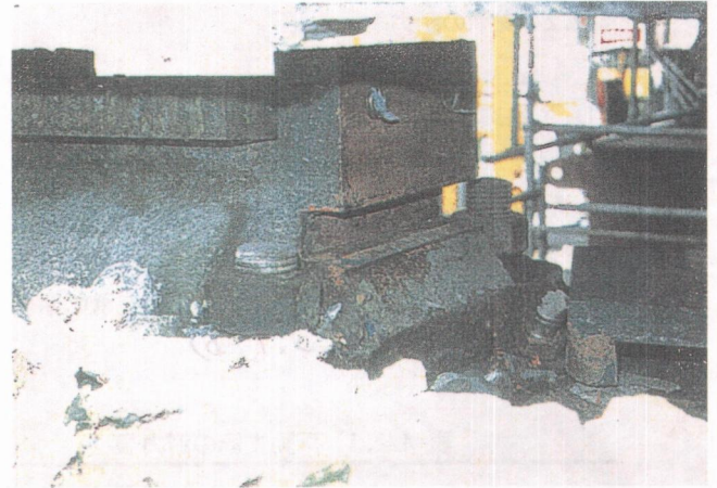
b) サイドブロックの固定ボルト破断
