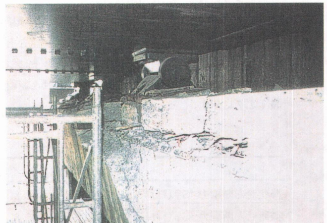
b) 固定支承沓座コンクリートの割裂・剥離
