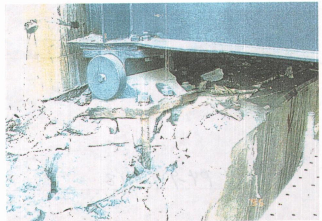
写真 1. 2. 18 P 4 支承損傷状況
