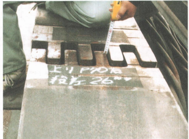
写真 1.2.6 P70 橋面段差状況
