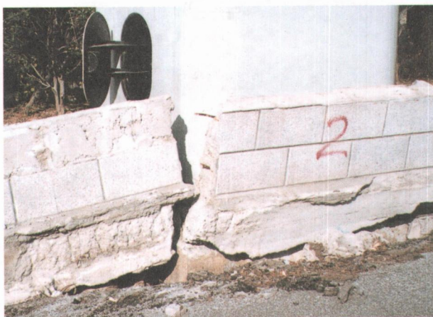
写真 1. 2. 12 橋脚基部損傷状況
