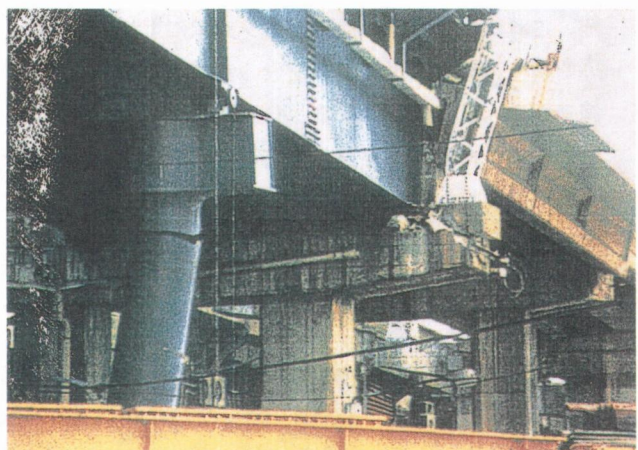
a) 架線用基礎コンクリートの割裂（可動）
