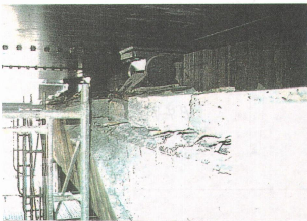
写真 1. 2. 15 P 4 掛け違い橋脚天端拡大写真
