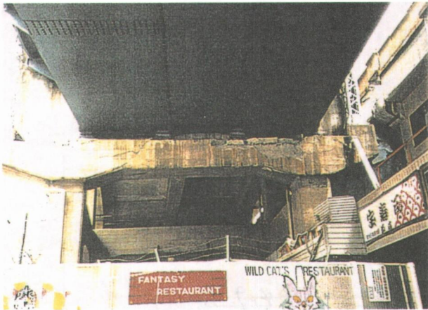
写真 1. 2. 14 P 4 掛け違い橋脚損傷状況
