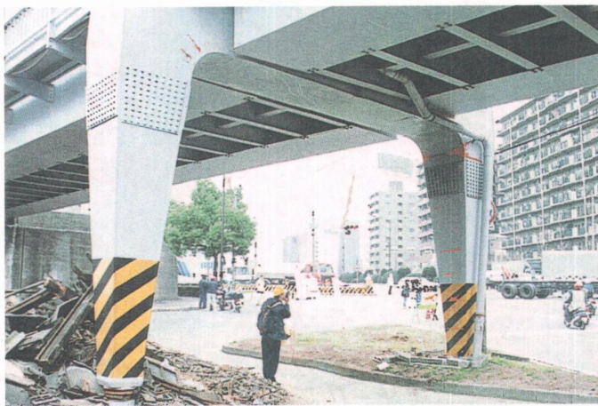
写真 1. 2. 23 P 2 橋脚ひずみ発生状況
