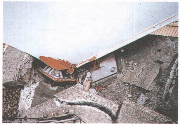
写真 4.1.2 A1 鉛直固定シューの損傷
