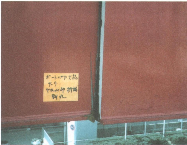
写真 1.2.1 ゲルバー部 桁端亀裂発生状況
