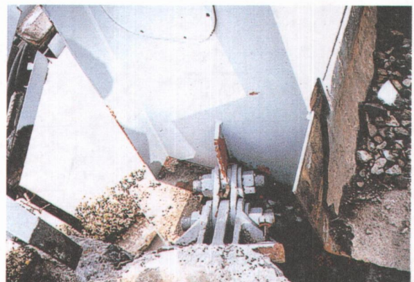
写真 4.1.3 A1 水平固定シューと桁端部の損傷
