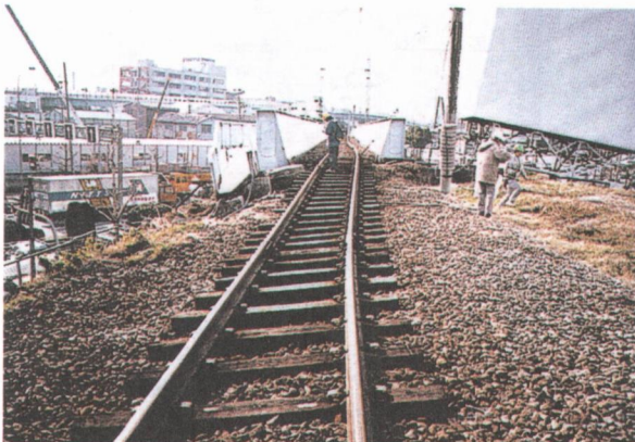
写真 4.1.1 橋軸直角ずれ (A1 橋台)
