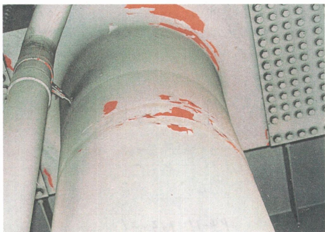
写真 1. 2. 21 P 1 橋脚ひずみ発生状況
