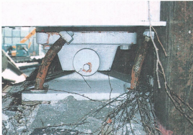
写真 1. 2. 24 A 2 支承損傷状況
