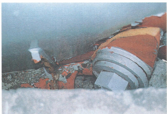
写真 1. 2. 20 A 1 桁水平シユール状況
