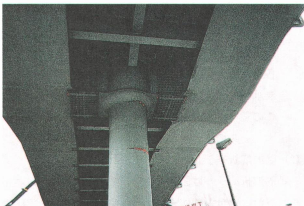
写真 4.1.4 P1 橋脚主桁剛結部の塗膜剥離
