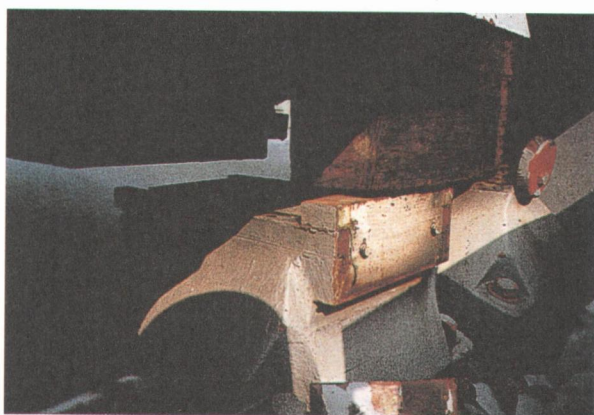
写真 4. 1. 7 P2 橋脚と主桁間の固定シューの分離移動
