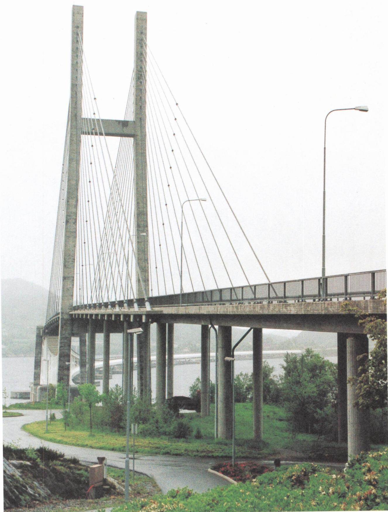
■ Norwayのポンツーン上に鋼桁を載せた橋梁 Salhus橋
