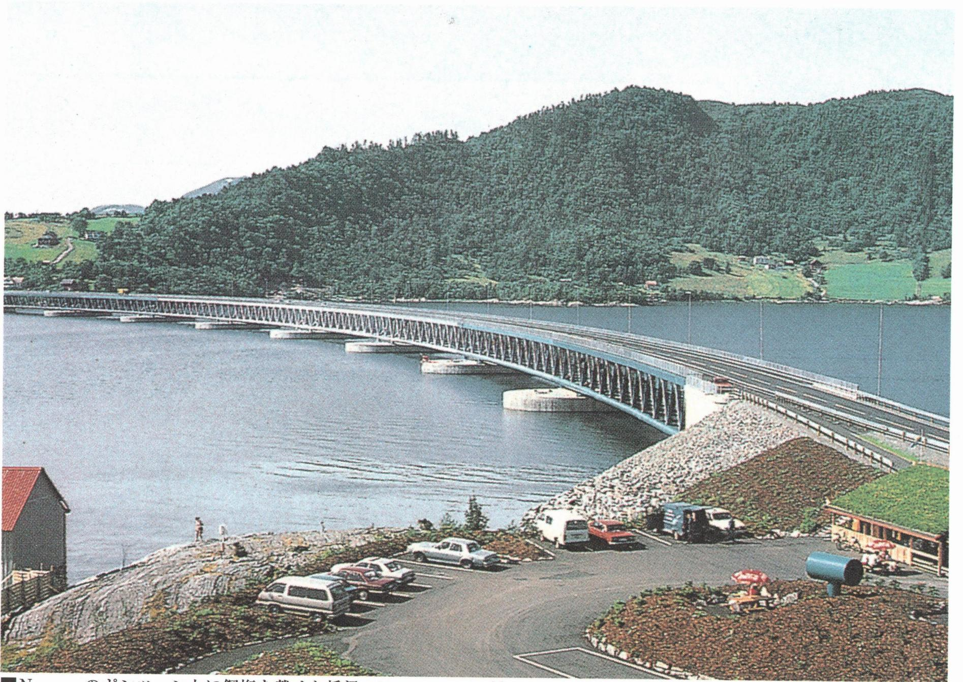
■ Norwayのポンツーン上に鋼桁を載せた橋梁 Bergsoyssund 橋
