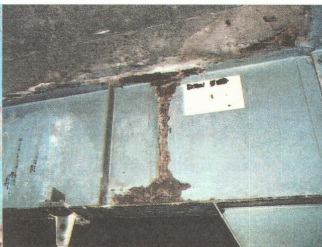
写真-7 横桁の腐食事例
