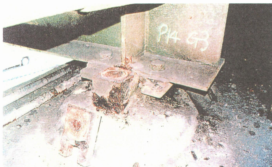
写真-26 線支承腐食事例
