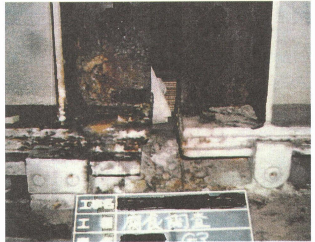
写真-2 鈑桁端部腐食事例
