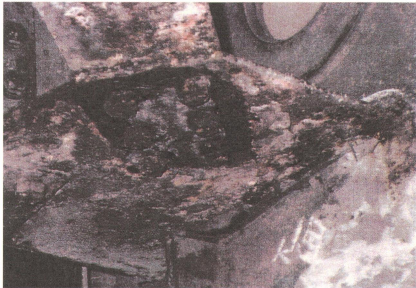
写真-32 ラテラルガセットの腐食事例
