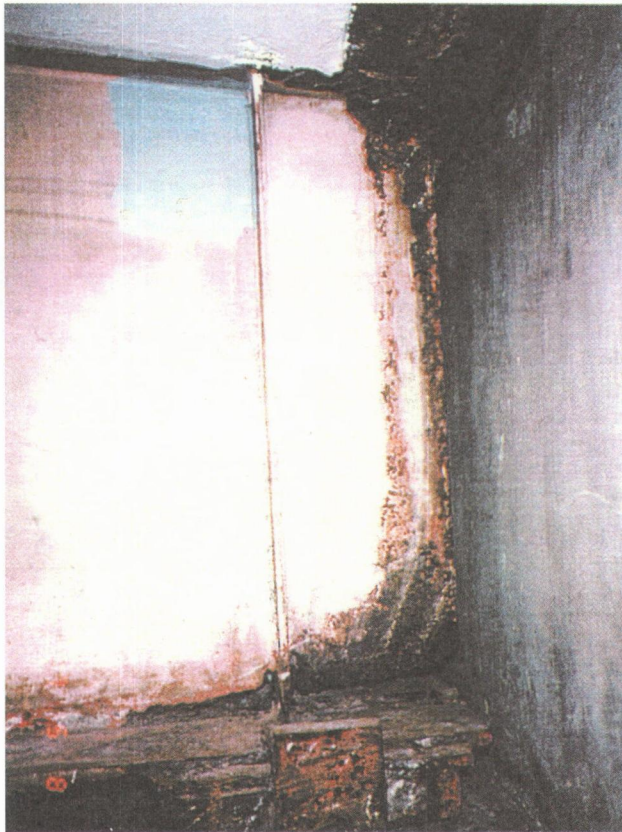
写真-1 鈑桁端部腐食事例
