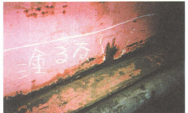
写真-3 鈑桁腹板下端腐食事例
