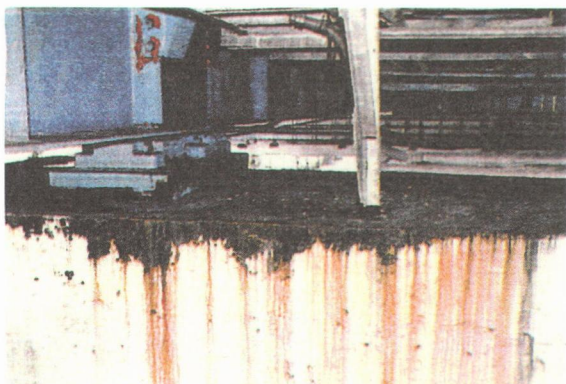
写真-16 橋脚外面腐食事例
