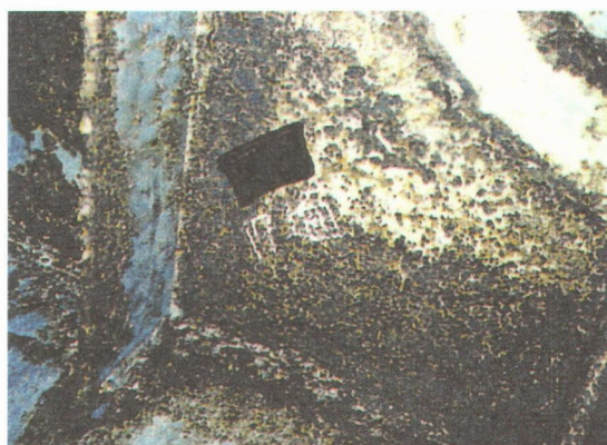
写真-17 橋脚内面腐食事例
