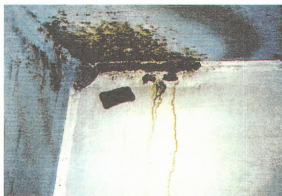
写真-20 橋脚内面腐食事例
