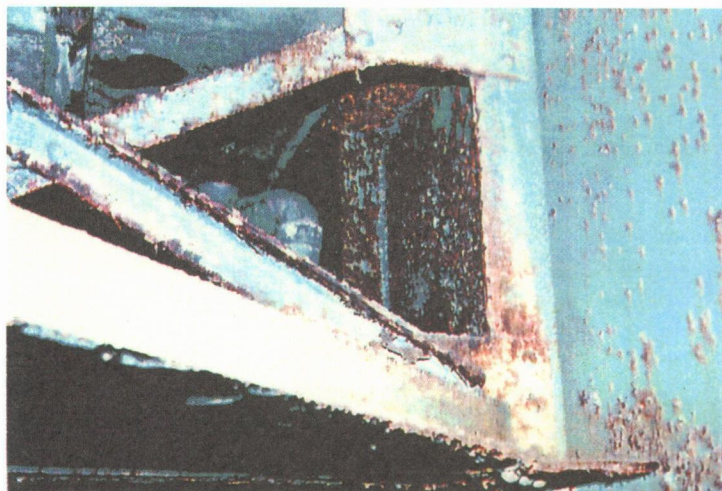
写真-6 対傾構の腐食事例
