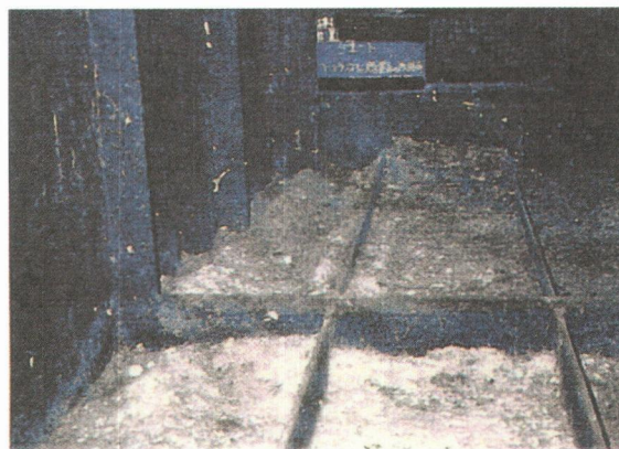
写真-15 鳩害による箱桁内面腐食事例
