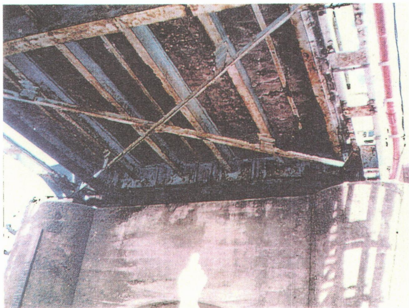
写真-21 トラス桁，縦桁横構腐食事例
