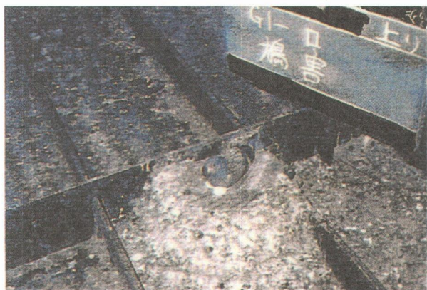
写真-15 鳩害による箱桁内面腐食事例
