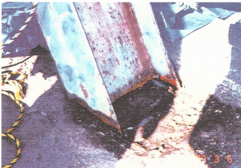
写真-33 トラス斜材の腐食事例
