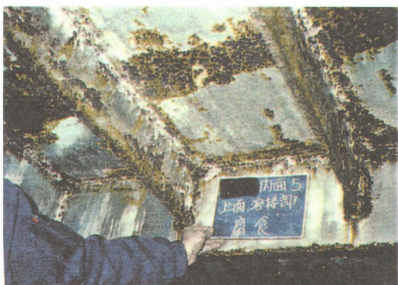
写真-17 橋脚内面腐食事例
