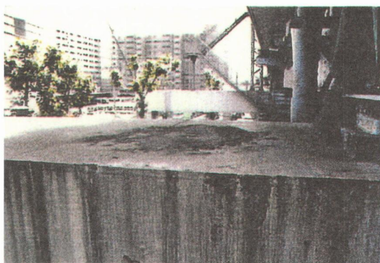
写真-16 橋脚外面腐食事例
