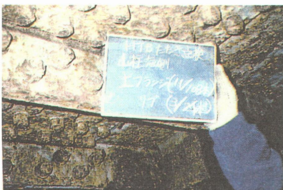
写真-18 橋脚内面継手部腐食事例
