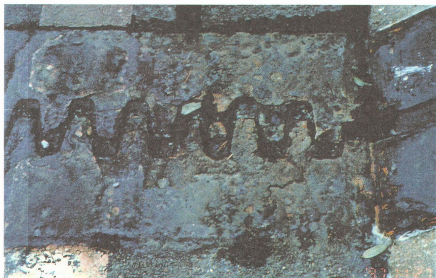
写真-27 伸縮継手腐食事例
