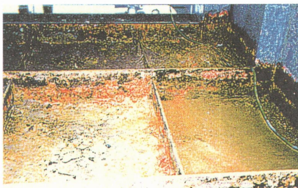
写真-14 橋脚内面腐食事例
