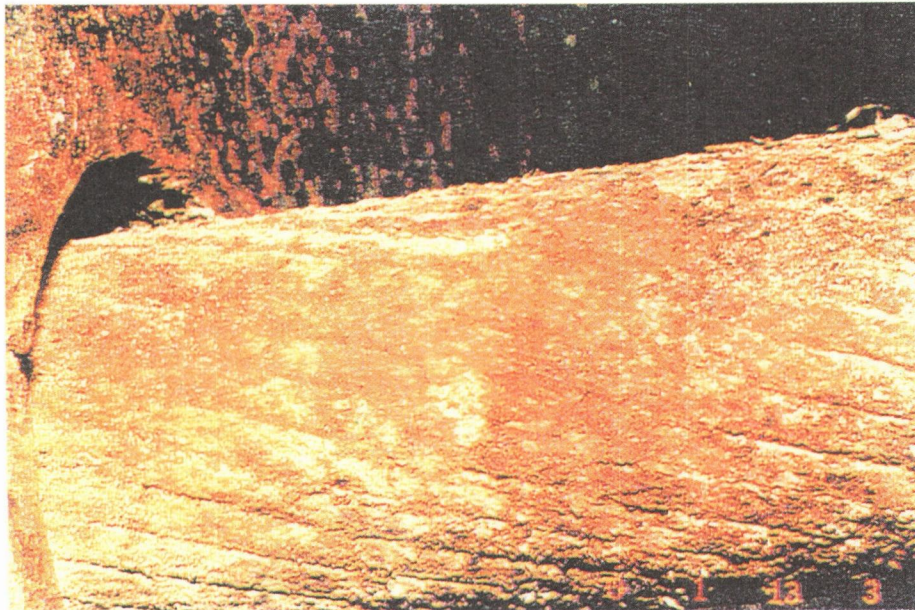
写真-35 ケーブル上面における腐食形成
