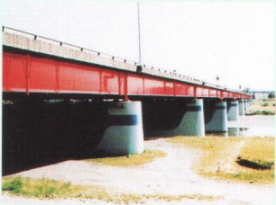
橋梁の主桁と同じ色彩の排水管の例
