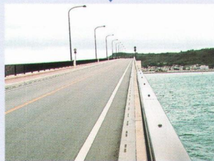
鋼製排水溝を用いた例
