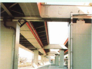
排水管を橋脚角線の角部に合わせた例
