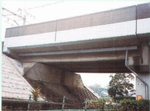
角形の排水管を用いて主桁の勾配に合わせた例
