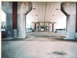
排水管にアクセントカラーを用いた例
