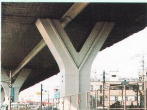
排水管を橋脚の形状に合わせて目立たなくした例
