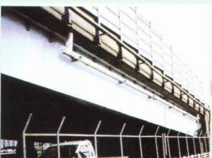
排水管を主桁の勾配に合わせた例
