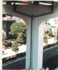
多角形の排水管を用いた例
