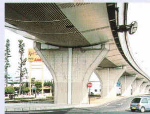
橋脚のスリット内に設置した例
