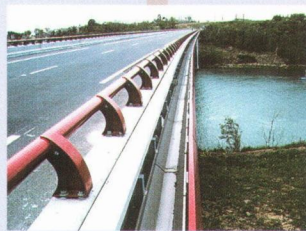
側溝を用いた例
