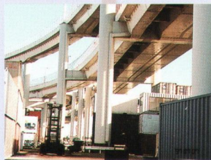
カバープレートで隠している例
