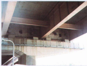
端横桁に設置した例
