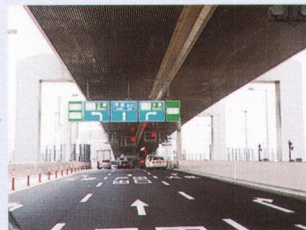
橋脚に設置した例
