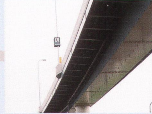
照明柱に添架した例
