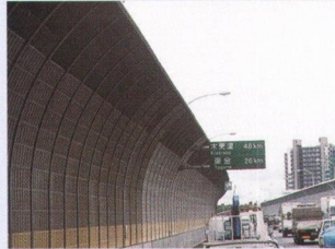
防音壁に設置した例
