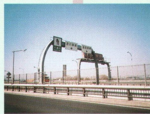
路線で統一された柱を用いた例
