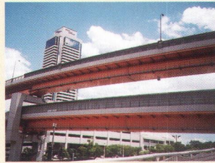
橋梁の主構造と対照調和させた例
