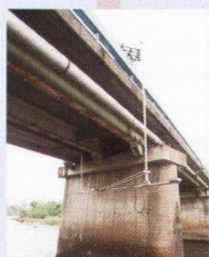
簡易点検装置を用いた例
