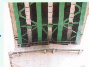
主桁間の全てに設置した例
