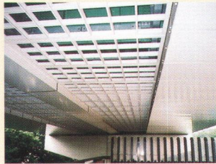
グレーチングを用いた例
