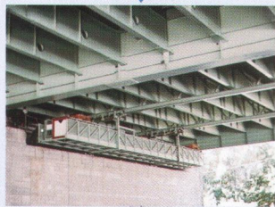
移動検査車を用いた例
