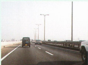
中央分離帯に設置した例
