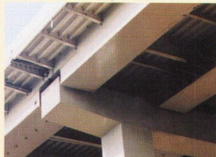
主桁を断面変化させて支承を設置した例
