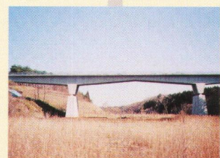
橋脚高さの中間に支承を設置した例
