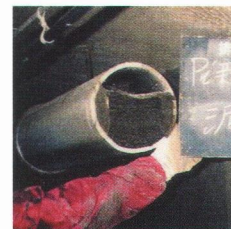
土砂詰まり状況
