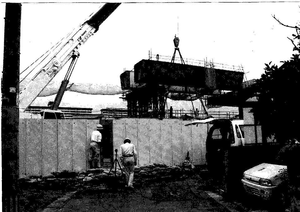
写真2-3 マイクロホンの設置状況(敷地境界付近)
