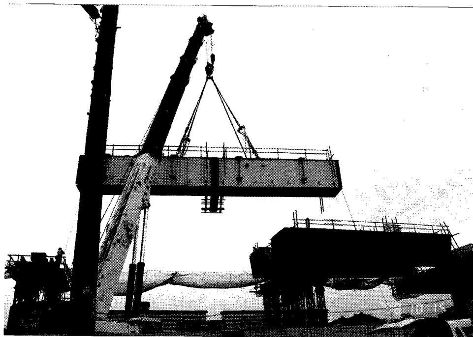
写真2-2 桁の架設状況
