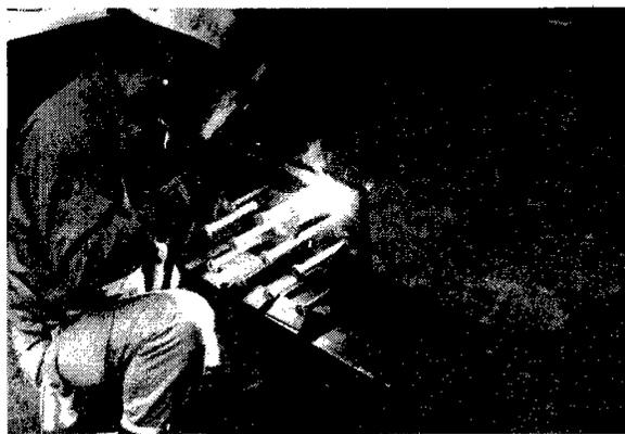
図 5-1 溶接補修横向き
