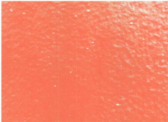
ウェブ面の厚膜エポキシ施工状況
