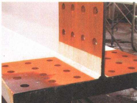
主桁ウェブ&下フランジ添接部錆発生状況
