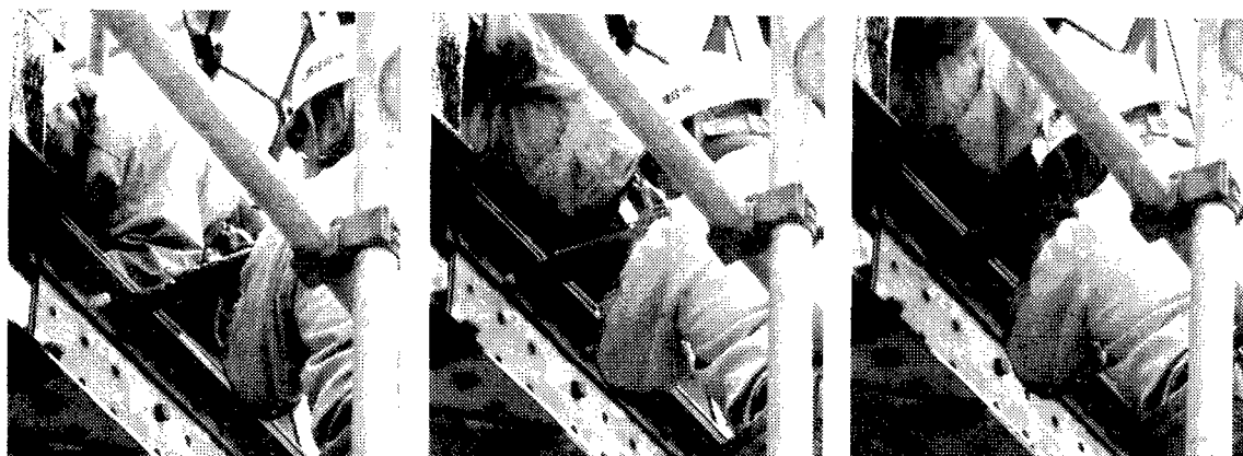
[写真-5.14.9：リベットハンマーによる締め付け]
