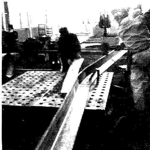
[写真-5.5.1：はちの巣による形鋼の曲げ作業 2) ]
