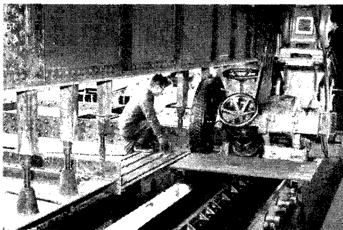
[写真-5.11.1：鈹桁端面の仕上げ作業 3) ]
