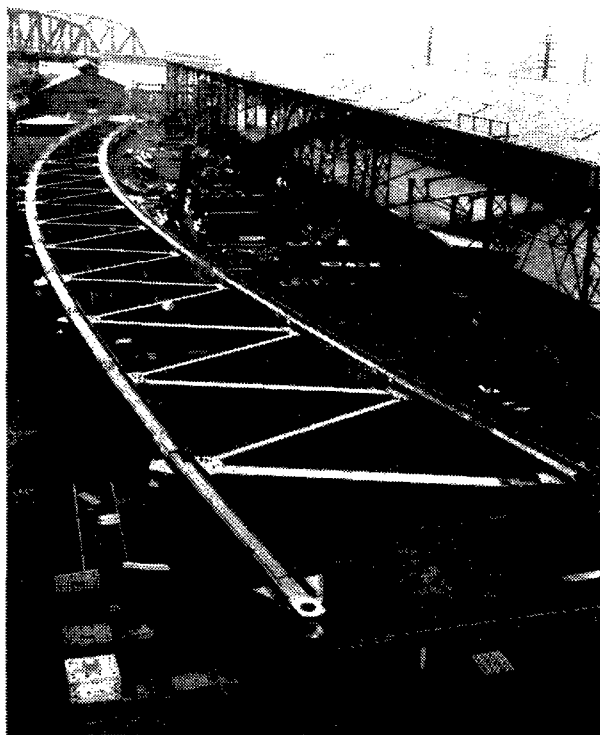
[写真-5.12.2：平仮組み（西海橋）]
