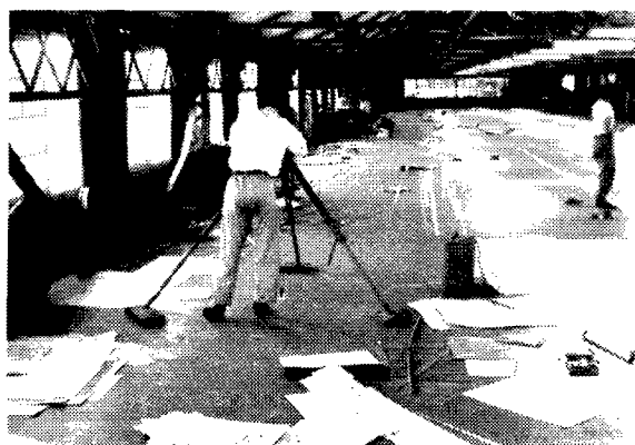
[写真-5.2.2：トランシットによる基準線設置 2) ]
