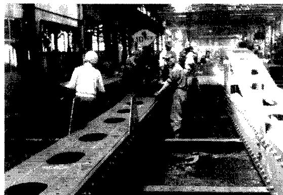
(4)反対側カバープレートの取付け
