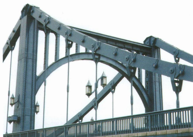
大きなアーチが印象的な主塔門構
