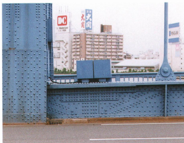
鉚結された架設ヒンジ部
