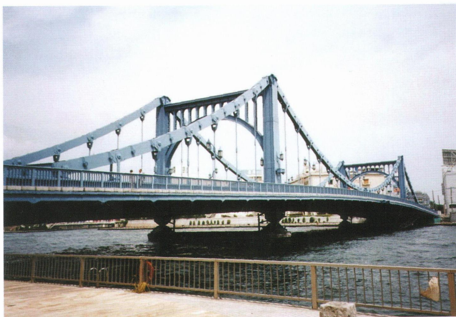
清洲橋の全景
