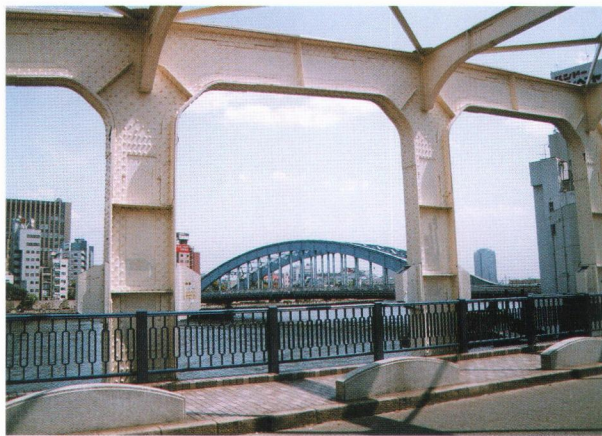
フィーレンデール越しに見る永代橋
