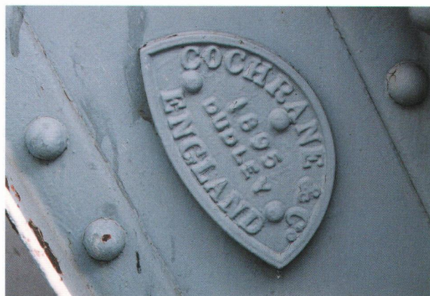
COCHRANE社製（1895）の銘板
