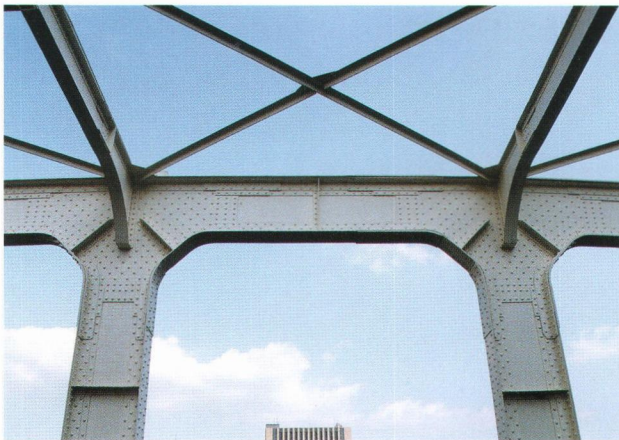
極力目立たないように設計された上横構
