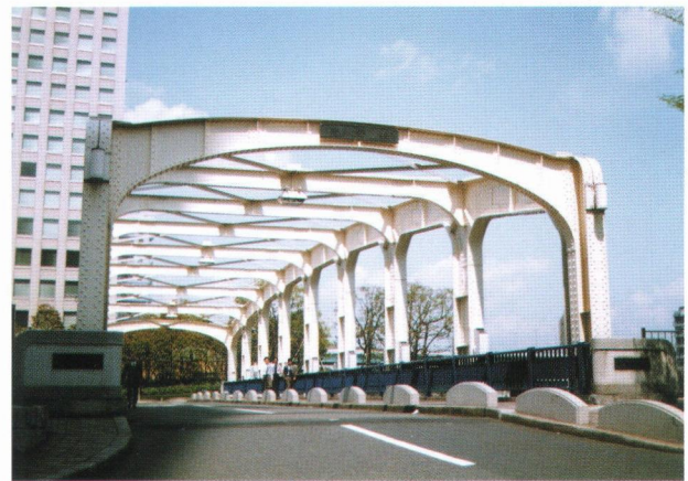
楕円曲線の橋門構
