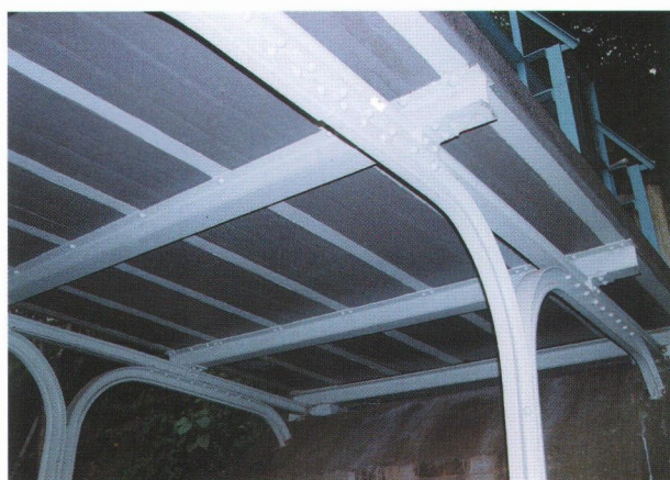
床版にもレールが埋め込まれている
