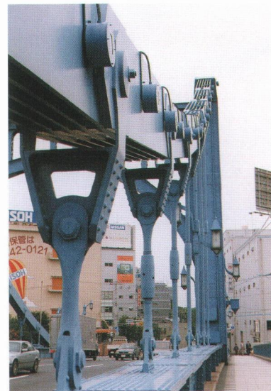
面外方向にも変形できる吊材
