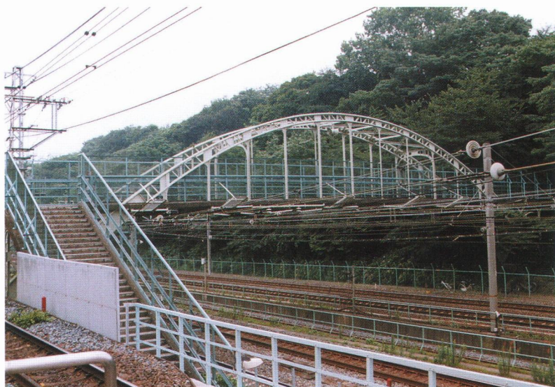
飛鳥山下跨線橋の全景
