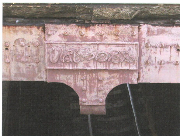
跨線橋には珍しい側面の橋銘板
