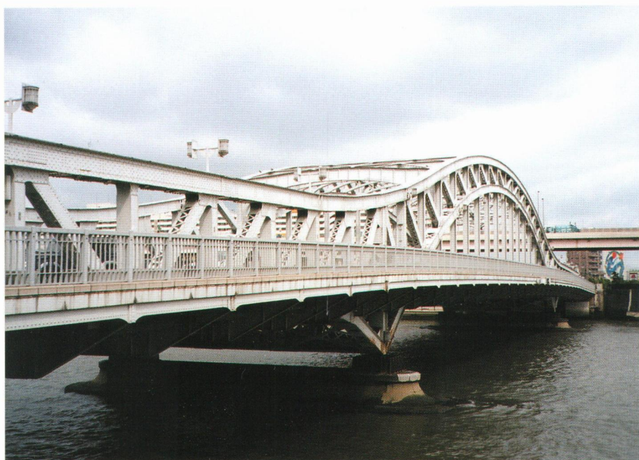
白鬚橋の全景
