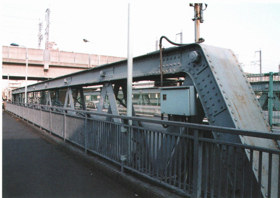
十条跨線橋の全景
