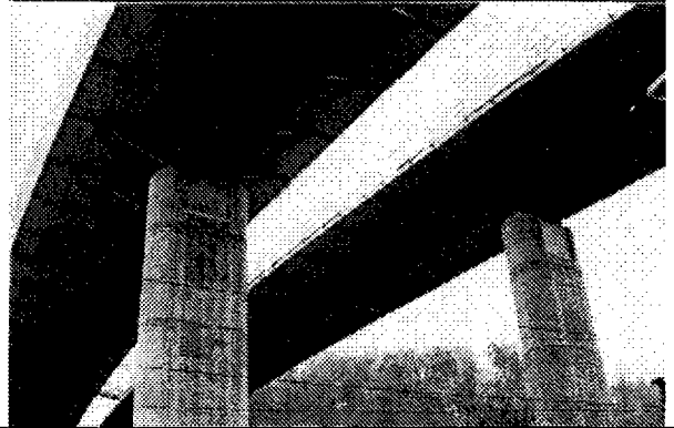
30. ドイツの橋③ (支間 134M、橋長 900M 5 径間連続鋼床版箱桁)
