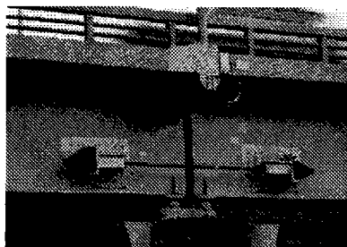
写真-1 一般的な落橋防止構造の例
