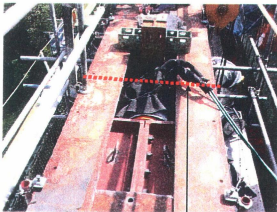
主構造弦材切断線
