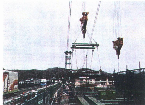
床版パネル撤去
