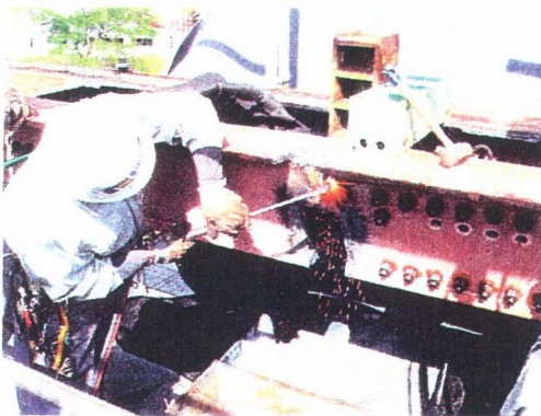
切断作業（ガス切断）
