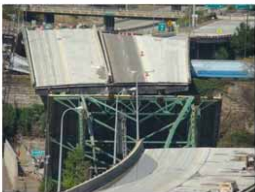
崩落した橋梁I-35W (2007.8.11)
