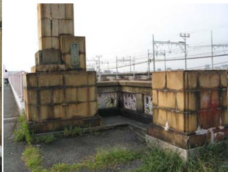
写真 4.11 親柱と橋詰高欄
