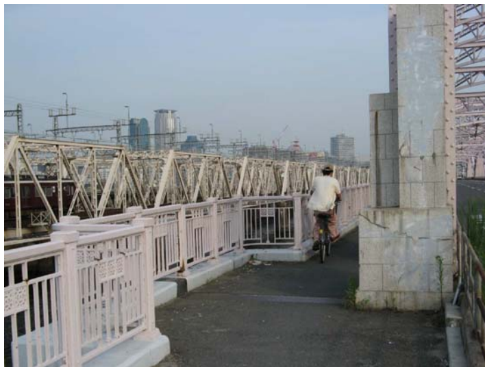
写真 4. 13 十三橋 橋梁部高欄(バルコニー)
