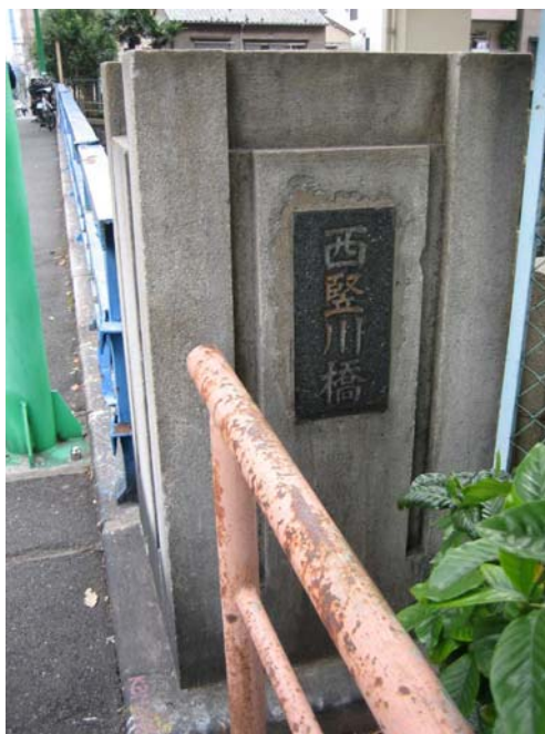
写真 4.15 108A（西堅川橋）の親柱
