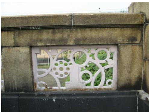
写真 4.10 十三橋 橋詰高欄の装飾
