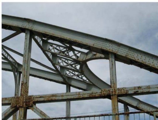
写真 4.19 伊勢大橋橋門構ポータル
