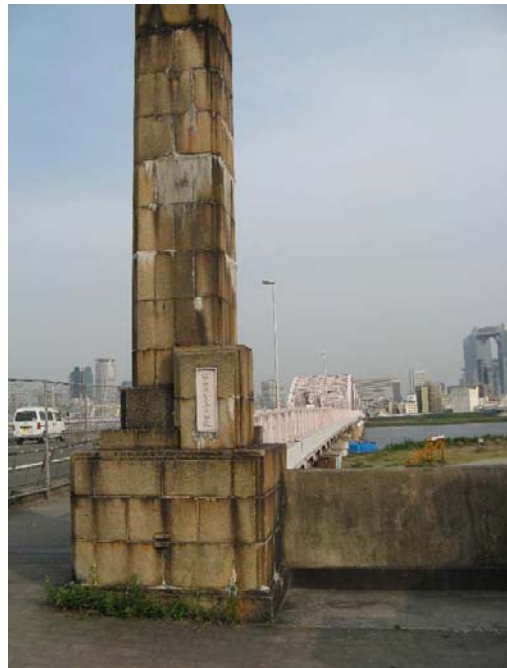
写真 4.9 十三橋親柱の現況 (平成 19 年 8 月 1 日撮影)
