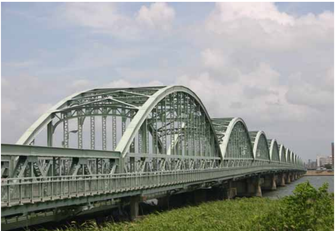
写真 4.2 尾張大橋 (木曽川橋) (撮影：2007 年 8 月)
