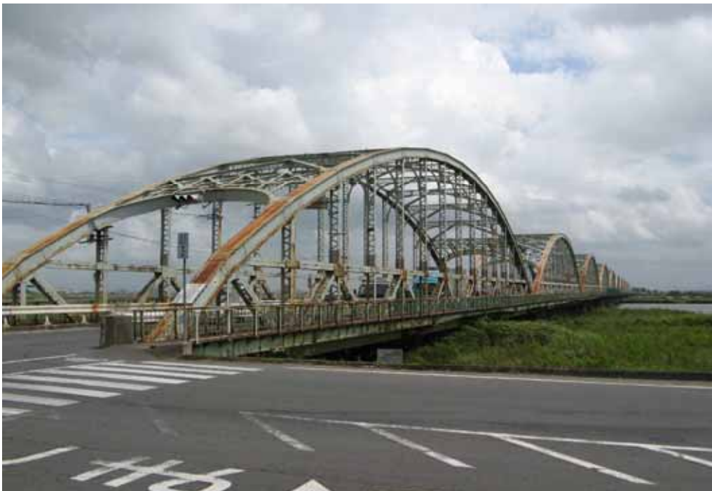
写真 4.3 伊勢大橋(揖斐長良川橋) (撮影：2007 年 8 月)
