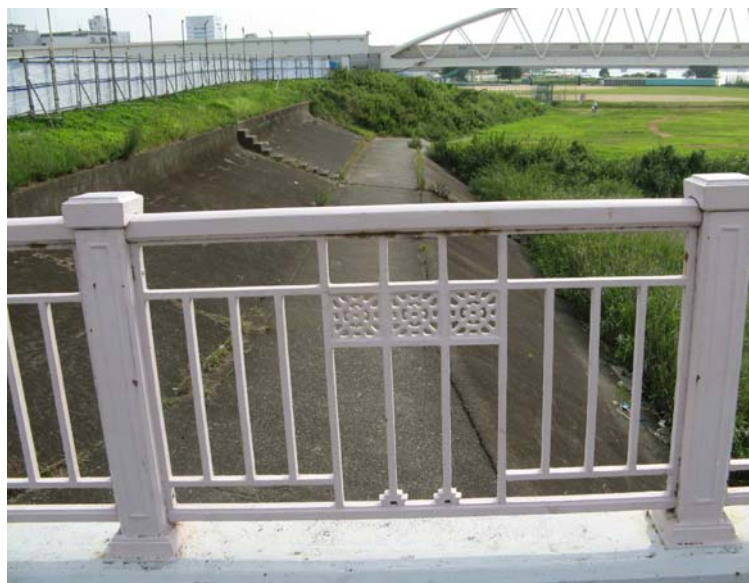
写真 4.12 十三橋 橋梁部高欄（撮影：2007 年 8 月）
