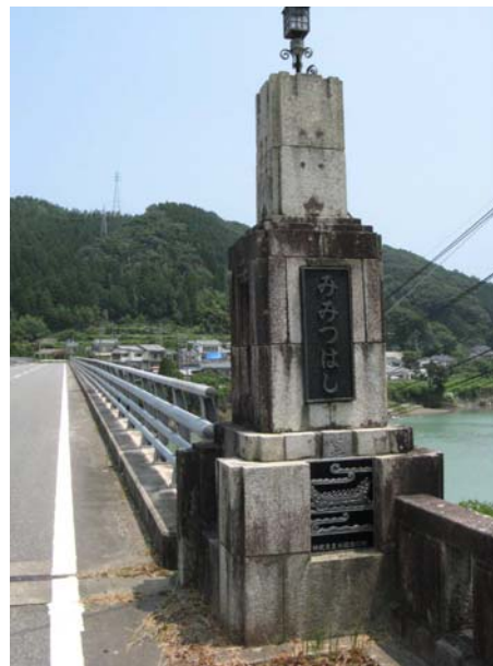
写真 4.8 美々津橋親柱現況（平成 19 年 8 月撮影）
