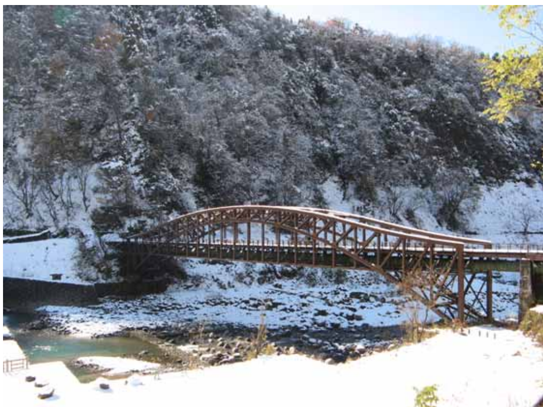
写真 4.5 常願寺川水路橋 (撮影：2007 年 11 月)
