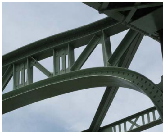
写真 4.20 尾張大橋橋門構造ポータル
