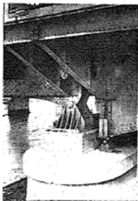
写真-5 桁橋固定沓
