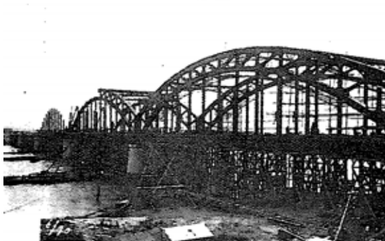
写真-8 アーチ部のベント架設
