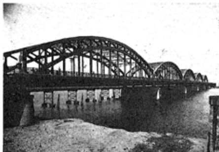
写真-1 上流側より全景
