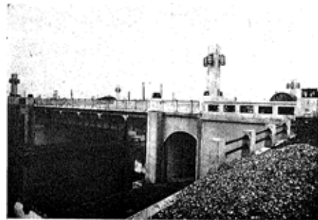
写真-2 十三小橋（上流側より）
