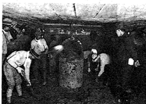
写真-7 ニュー-マチックケーソン内部の作業状況
