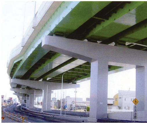
写真 2.4.2 従来型箱桁の例
