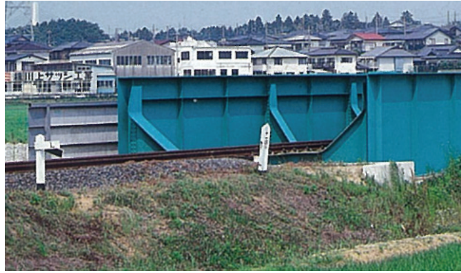
写真 2.4.1 鉄道橋のニーブレス構造の例
