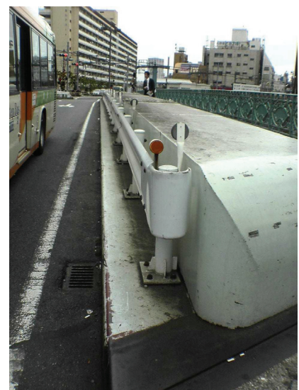
写真 2.4.7 ハッ山橋(防護柵あり)
