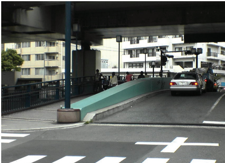
写真 2.4.6 前田橋(防護柵なし)
