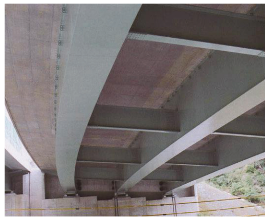
写真 2.4.3 細幅箱桁の例
