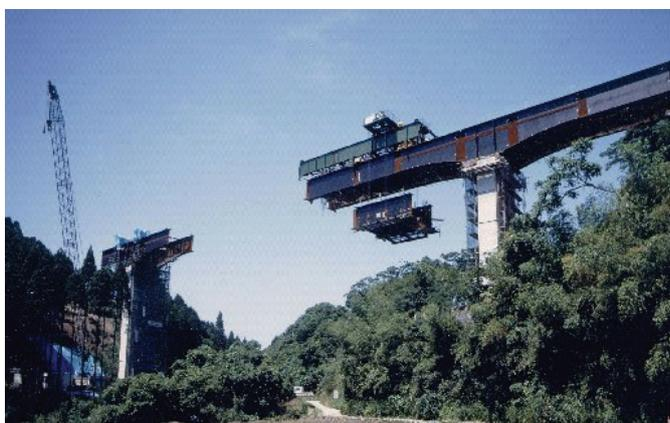
写真 2-6-2 TEG クレーン工法架設状況
