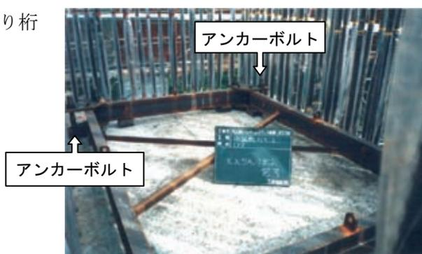
写真 2-6-6 アンカーボルトによる固定事例
