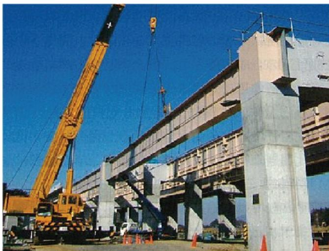
写真 2-6-1 トラッククレーン工法架設状況
