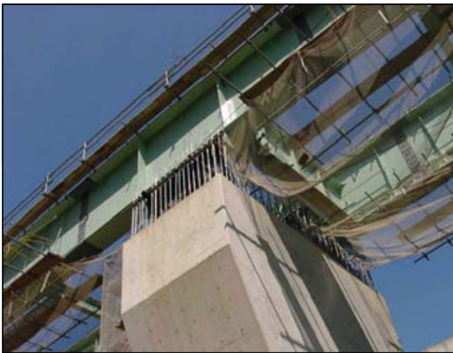
写真 3-2 剛結部鋼桁部構造(1)（高月橋）
