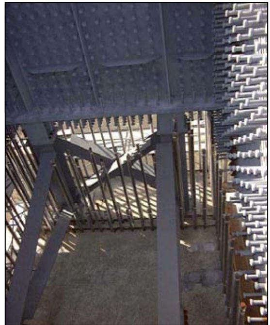
写真 3-3 剛結部鋼桁部構造(2)（高月橋）
