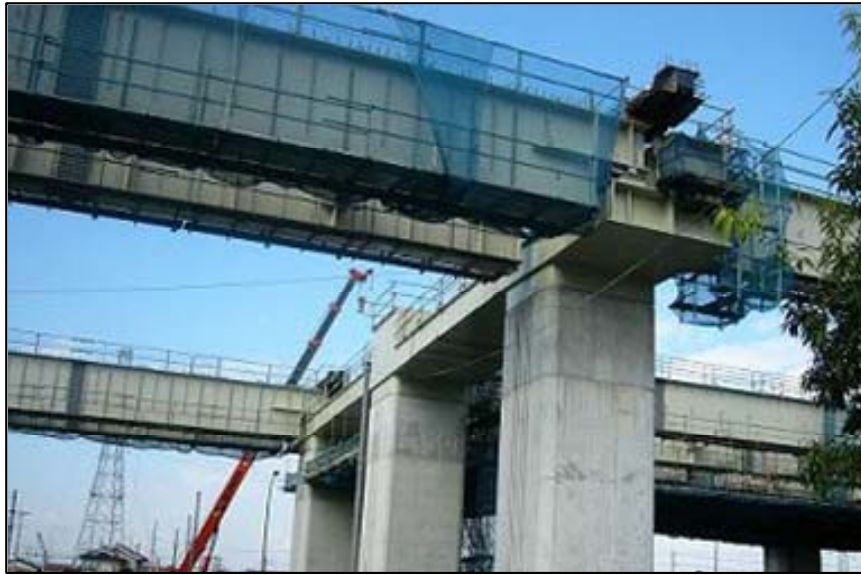
写真 3-1 剛結部全体構造（鷹野南高架橋）
