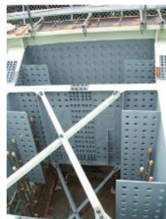
写真 2-1-2 剛結部構造
