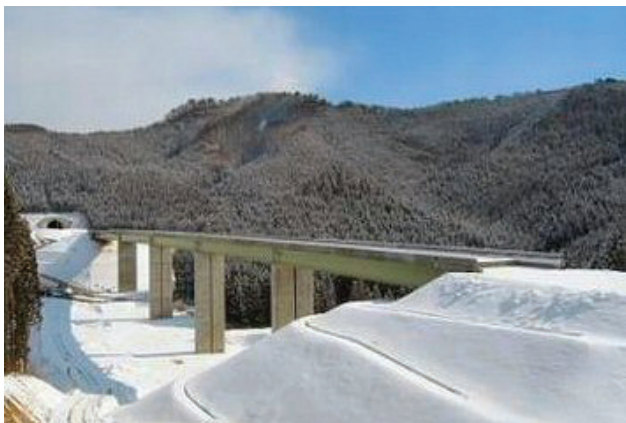
写真 2-1-1 複合ラーメン橋（全景写真）
