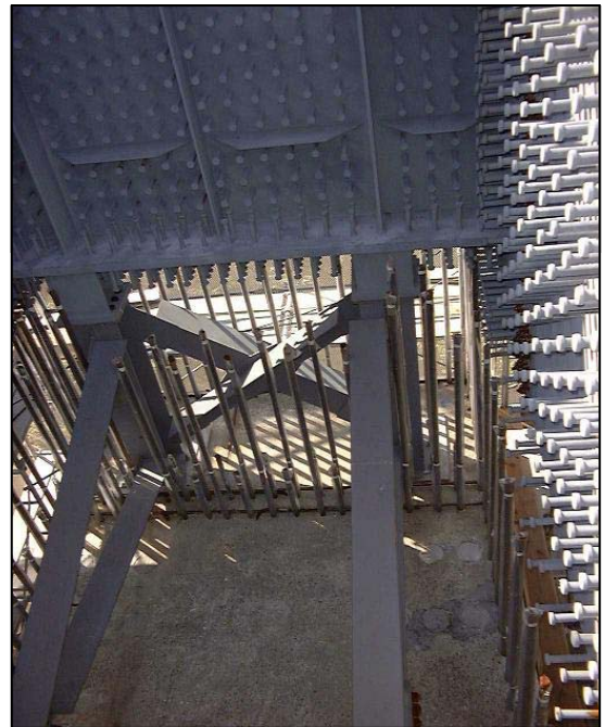
写真 3-3 剛結部鋼桁部構造(2)（高月橋）
