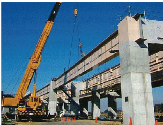
写真 2-6-1 トラッククレーン工法架設状況
