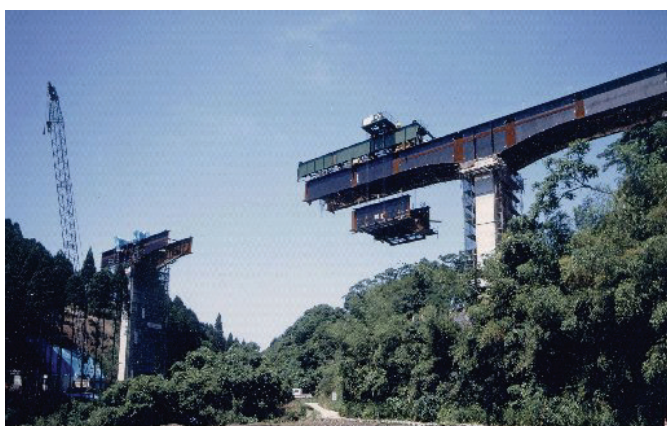
写真 2-6-1 トラッククレーン工法架設状況
