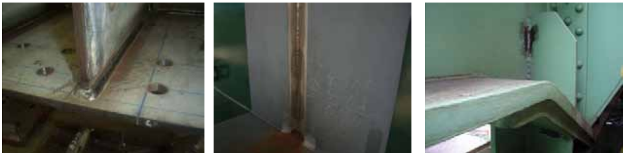
(a)工場溶接部
