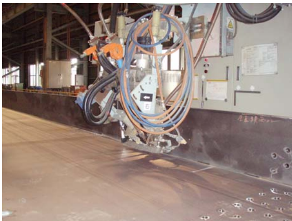
写真-2.1 サブマージアーク溶接
