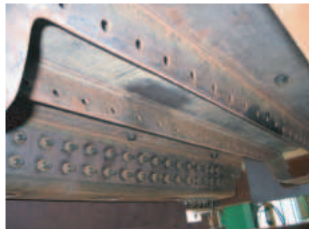
写真-3 前作業完了時の状況
