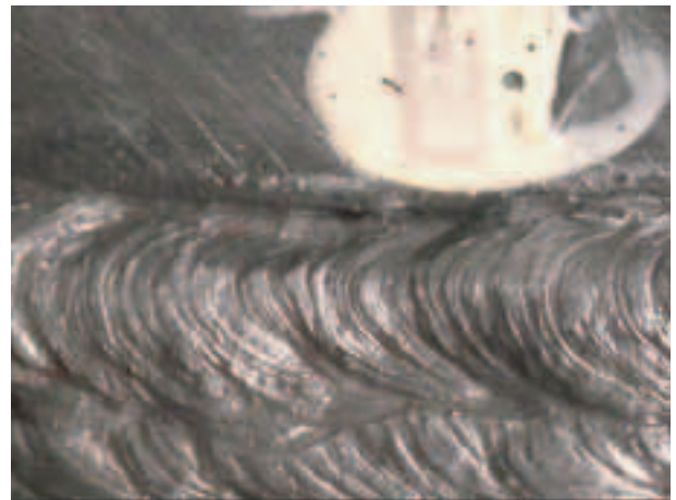
(b) マイクロスコープによるき裂部状況
