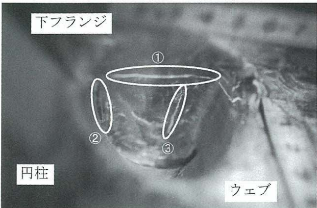
写真-13 MTウェブ母材コバ面のき裂
