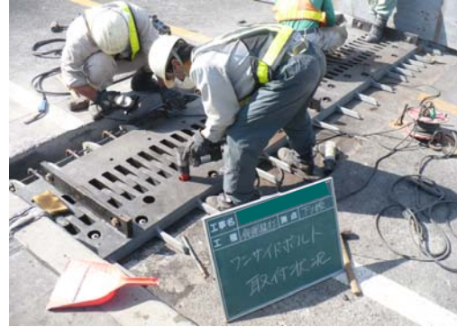
ボルト締め付け状況
