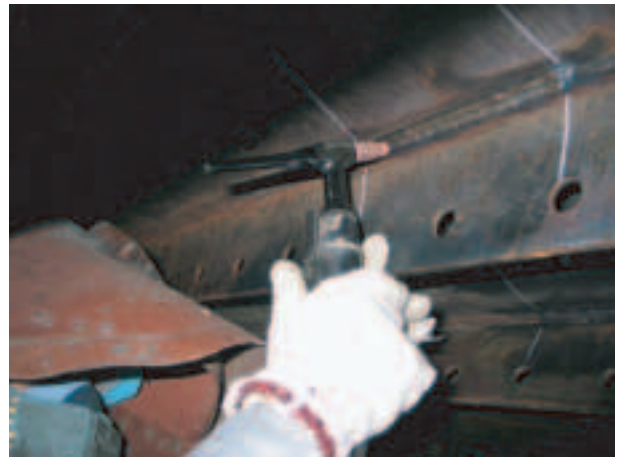
写真-5 雨樋型のTIG ドレッシング
