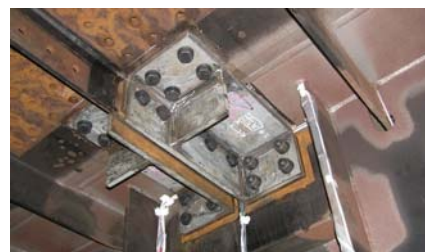
図1 鋼製橋脚横梁における当板補強例
