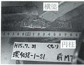
写真-1 横梁ウェブと円柱の交差部
