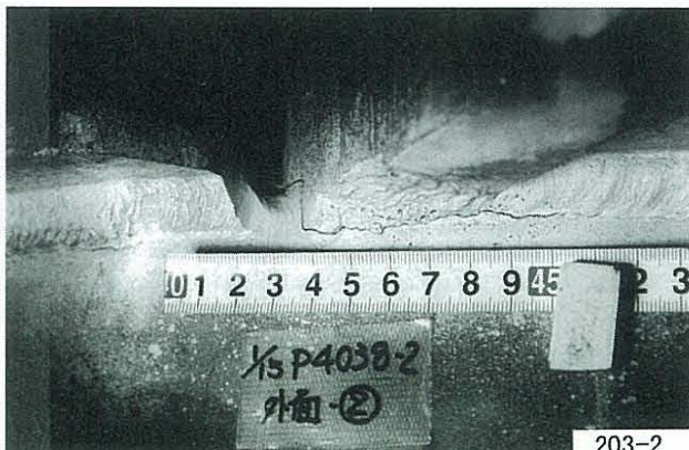
写真-9 差込ウェブ隅角のき裂
