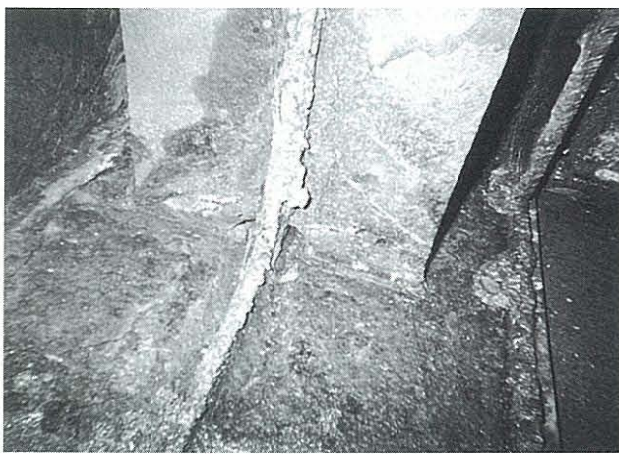
写真-8 支承受台内部腐食
