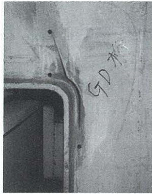
写真-2 主桁桁端切欠き部
