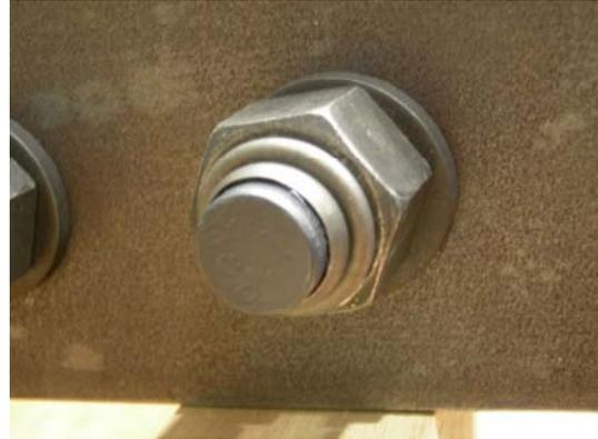
写真-16 ワンサイド高力ボルト締結後
