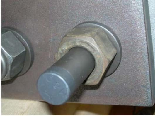
写真-15 ワンサイド高力ボルト締結前
