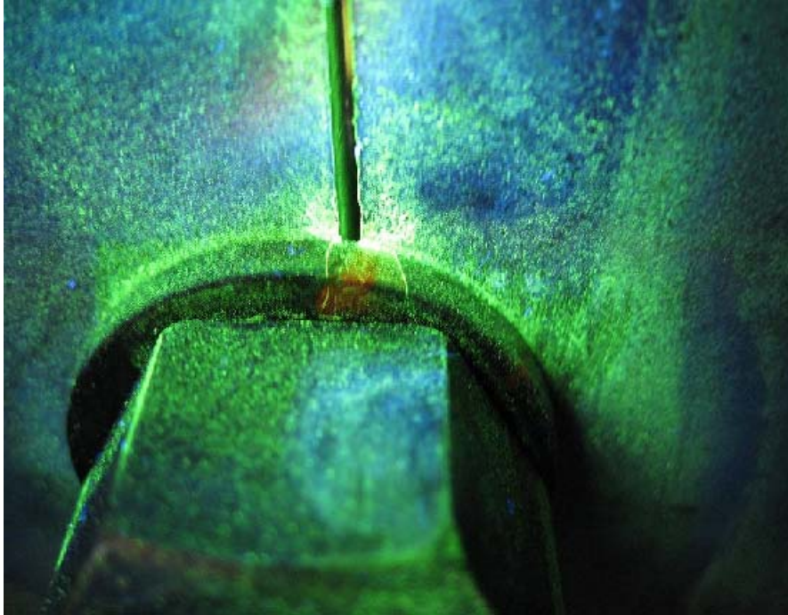
写真-16 HTB1 ナット側ワッシャーの疲労き裂
