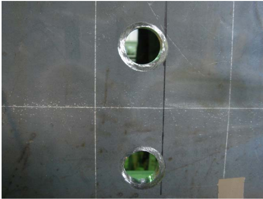
写真-4 ストップホールのグラインダによるバリ取り後
