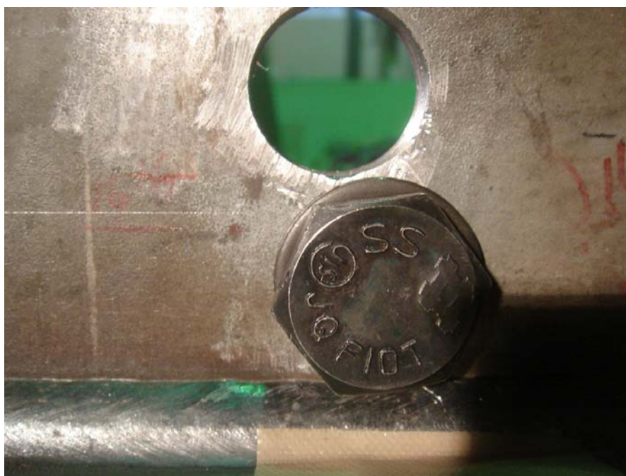
写真-13 SH3 の M16 によるボルト止めストップホール工法の補修
