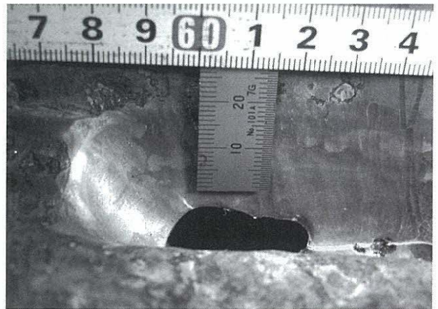
写真-15 カバーPL端部の除去
