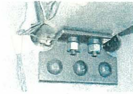
写真-2 対策工の実施状況
