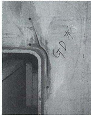
写真-2 主桁桁端切欠き部
