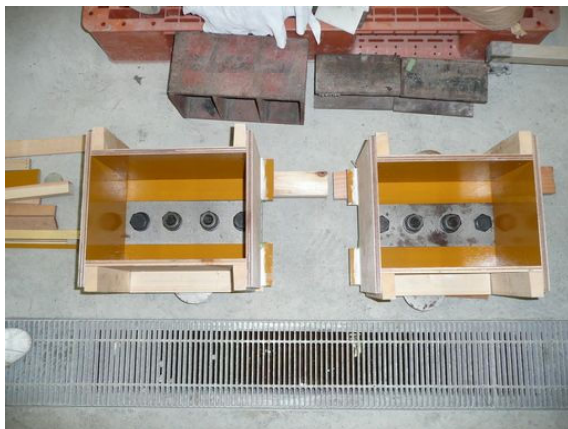
写真-8 型枠作成後
