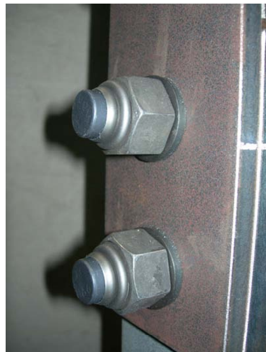
写真-2 4 すべり後のナット側状況
