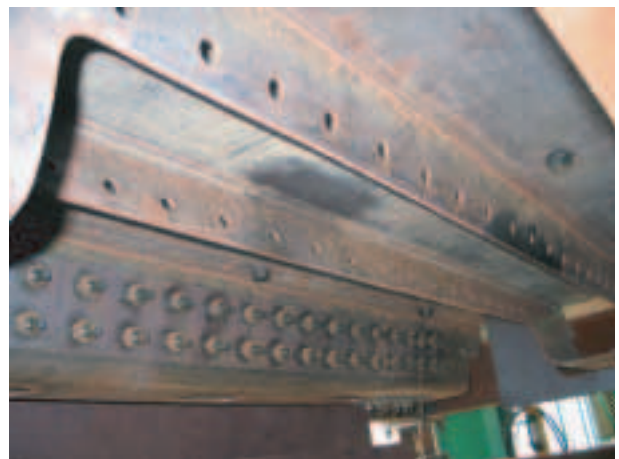
写真-3 前作業完了時の状況
