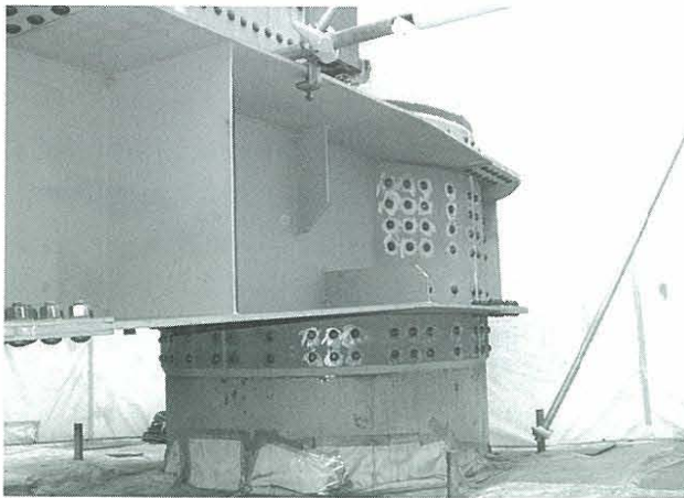
写真-6 円柱部の取付状況
