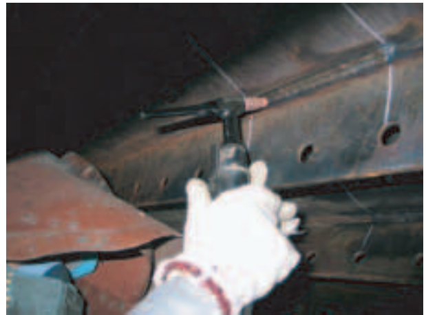
写真-5 雨樋型のTIG ドレッシング
