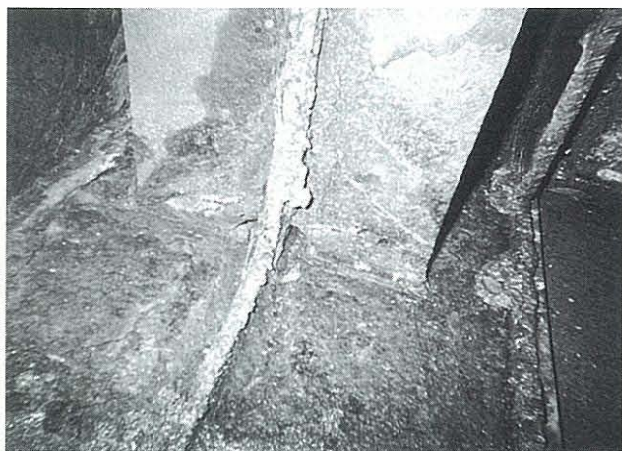
写真-8 支承受台内部腐食
