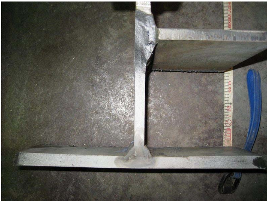
写真-23 鋼桁破断下フランジ（切出し）
