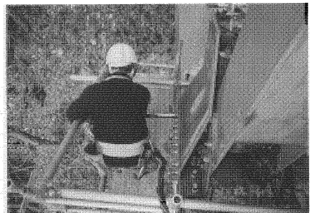
写真-1 ガセットプレートの接合
