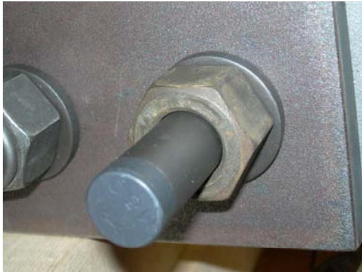
写真-15 ワンサイド高力ボルト締結前
