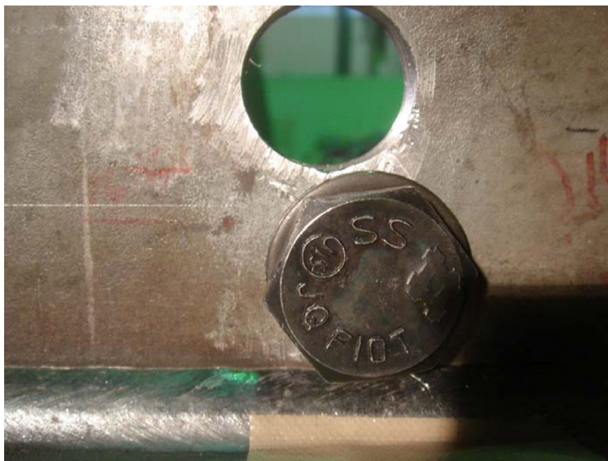
写真-13 SH3 の M16 によるボルト止めストップホール工法の補修
