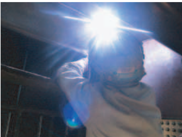
写真-8 TIG ドレッシング施工状況
