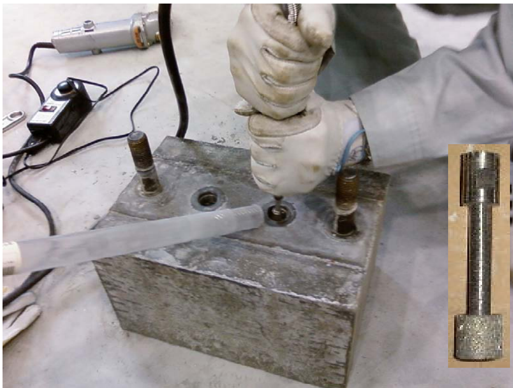
写真-10 超硬ロータリーバーによる床版内ナット切削作業
