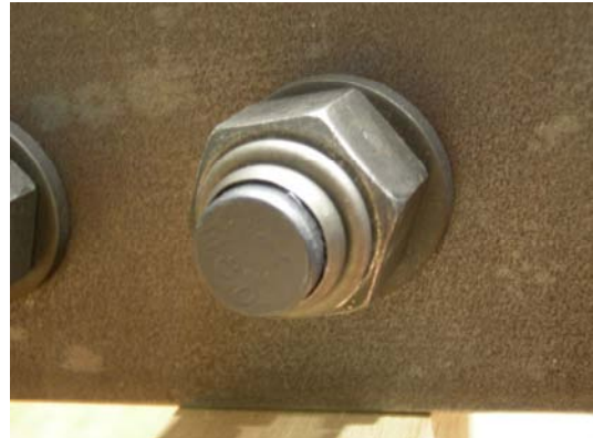
写真-16 ワンサイド高力ボルト締結後
