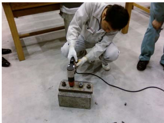
写真-11 専用シアレンチでボルト締結
